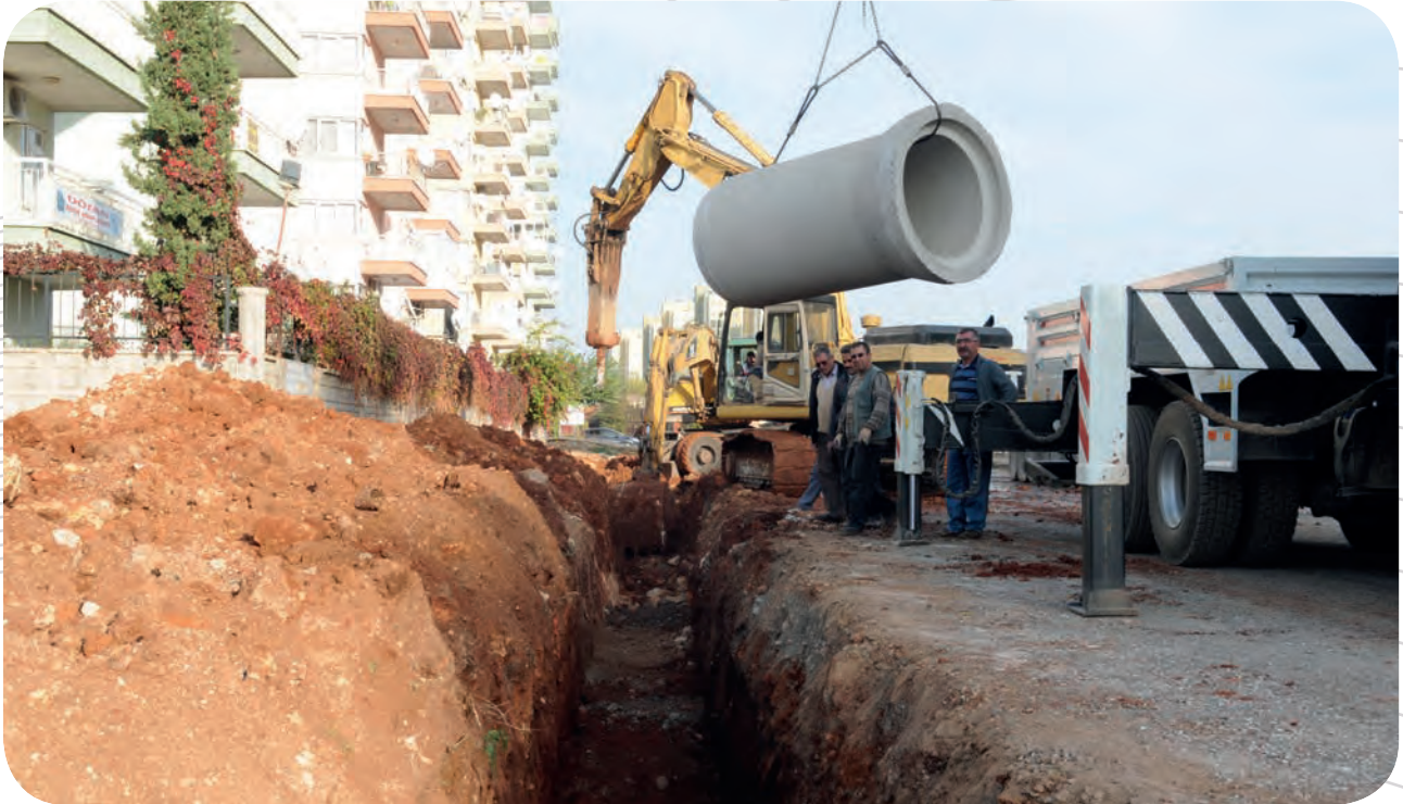
Yağmur Suyu Drenaj Çalışması
