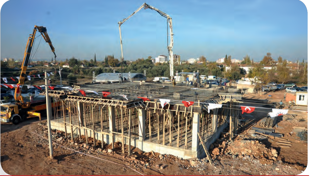
Gazi Mahallesi Semt Konağı Temel Atma Çalışması
