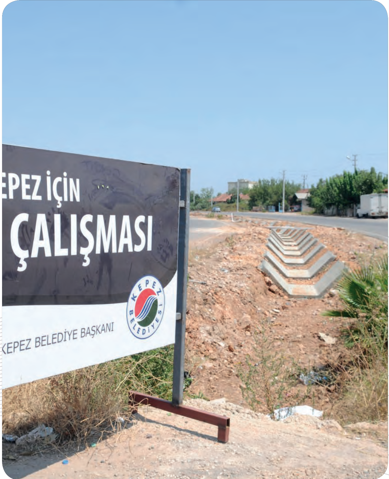
Gazi Mahallesi Trapez Kanal Yapımı
