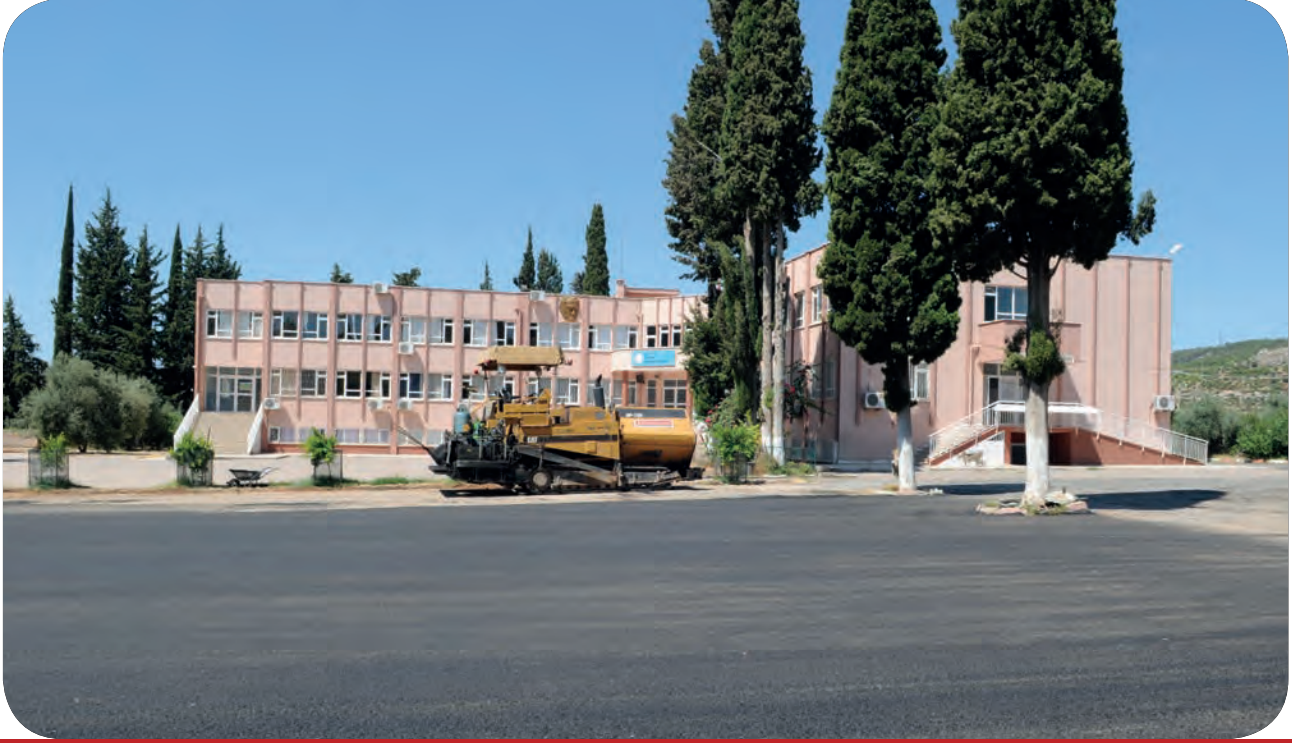
Varsak İlköğretim Okulu Bahçesine Sıcak Asfalt Serme Çalışması
