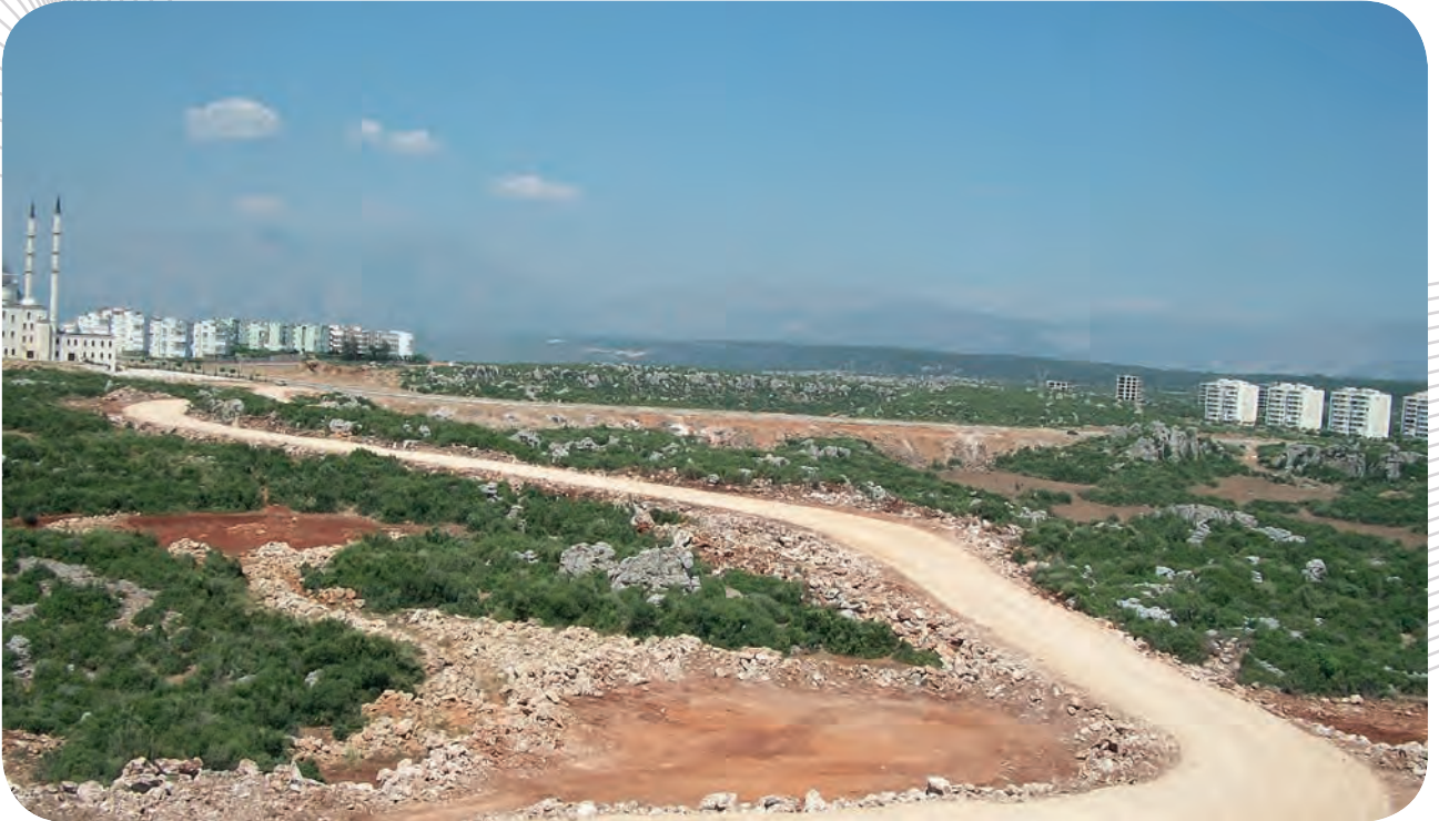
Çankaya Mahallesi Uyaroğlu Camii Yeni Yol Açım Çalışması (Sonraki Hali)
