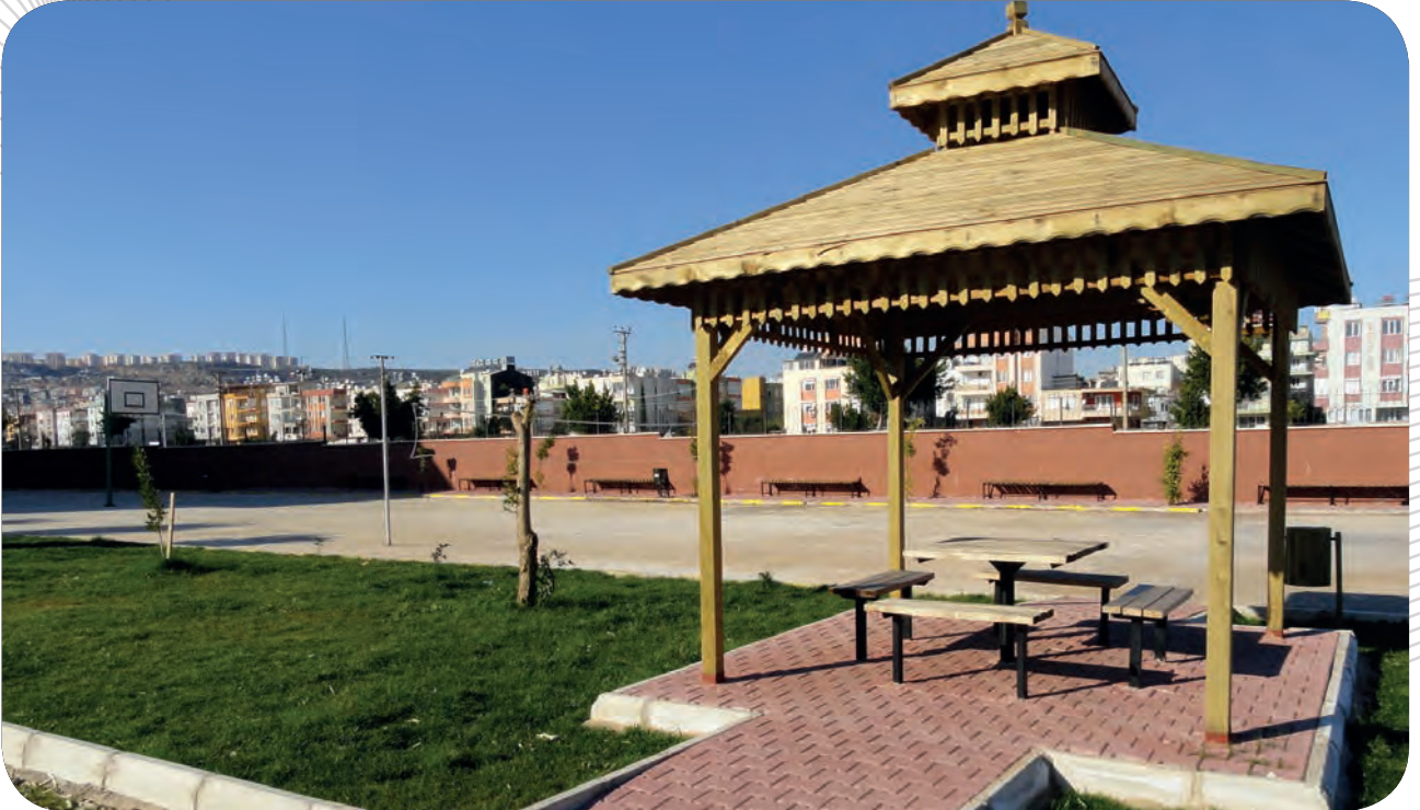
Yeni Mahalle Nevzat Saygan Anadolu Lisesinde Pergola Montajı Yapıldı
