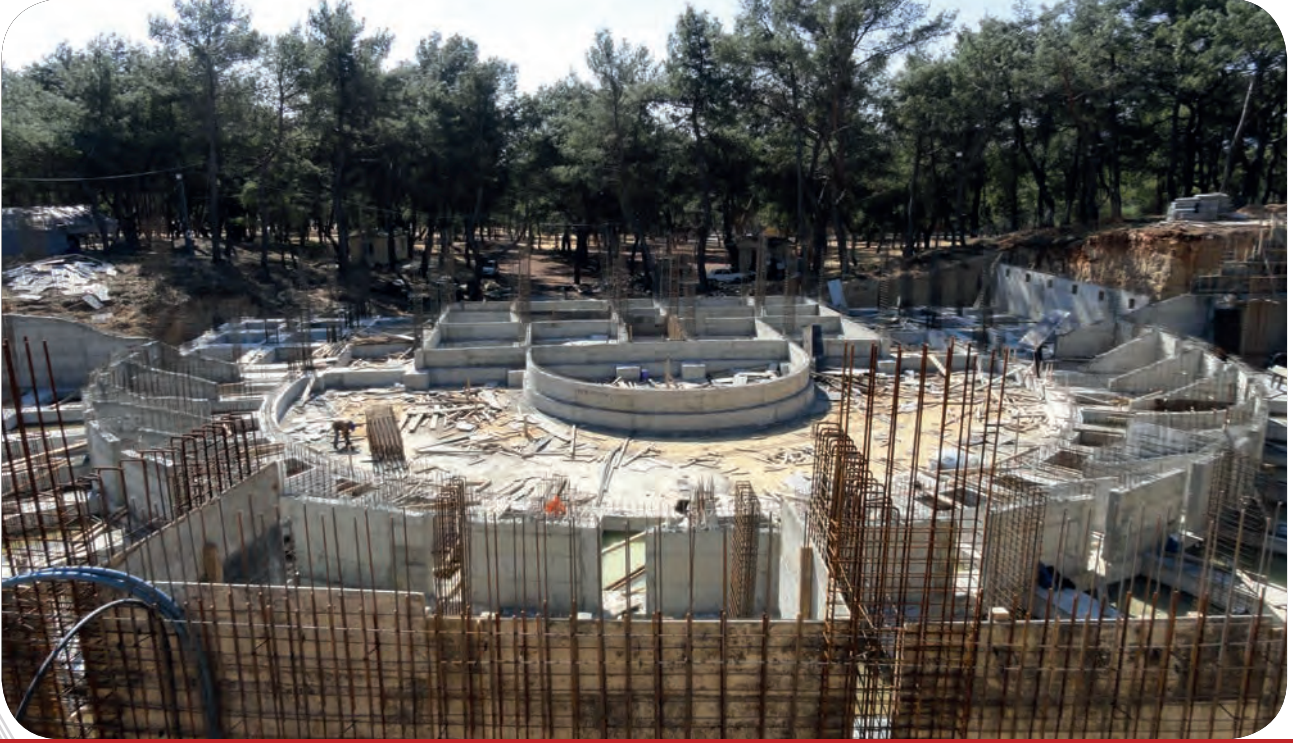
Amfi Tiyatro İnşaatı Son Hali
