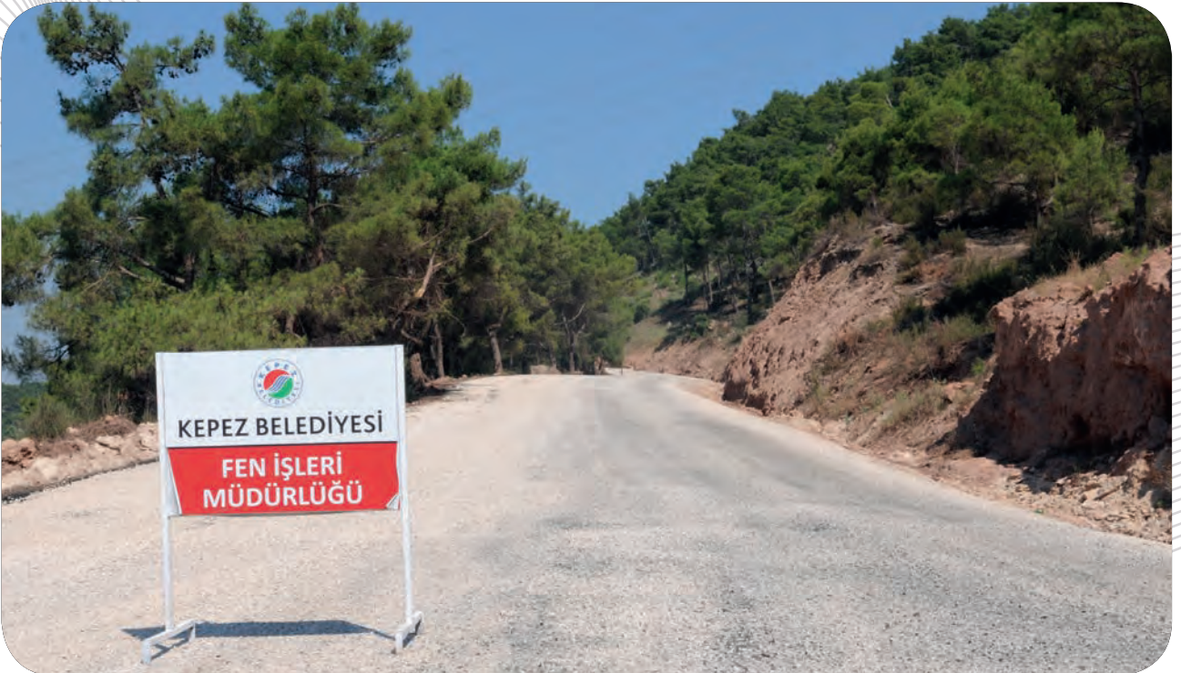
Varsak Karşıyaka Mahallesi Kındıra Yolu Sathi Kaplama Bitmiş Hali
