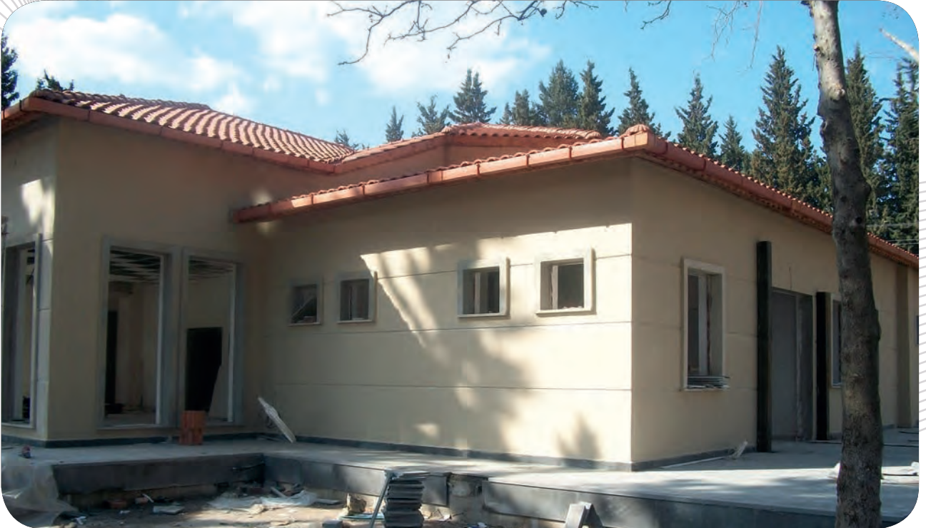
Butik Kültür Merkezi İnşaatı Devam Etmektedir.
