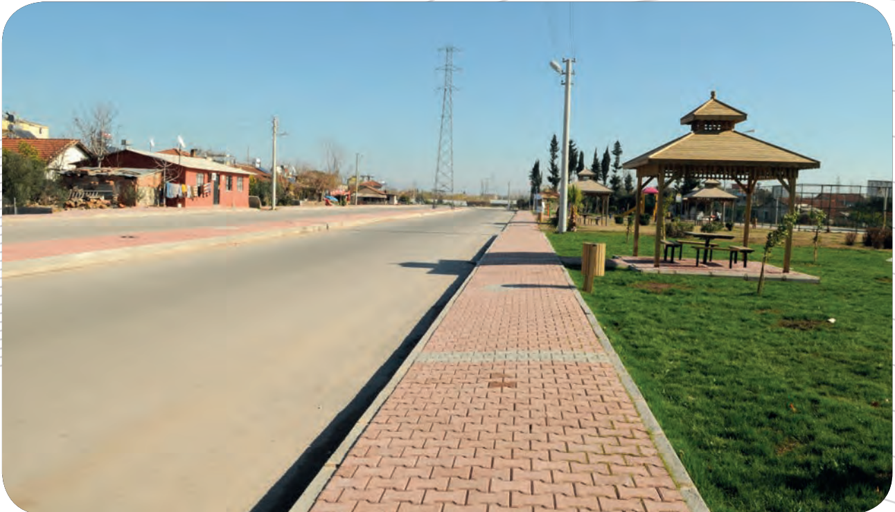
Hüsnü Karakaş Mahallesi 3643 Sokak Prefabrik Beton Kaldırım Çalışması
