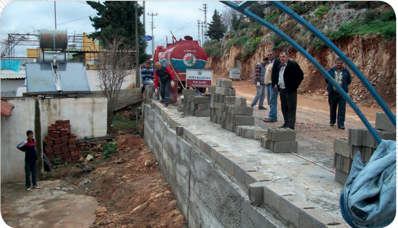
Göçerler Mahallesi İstinat Duvarı Yapım Çalışması
