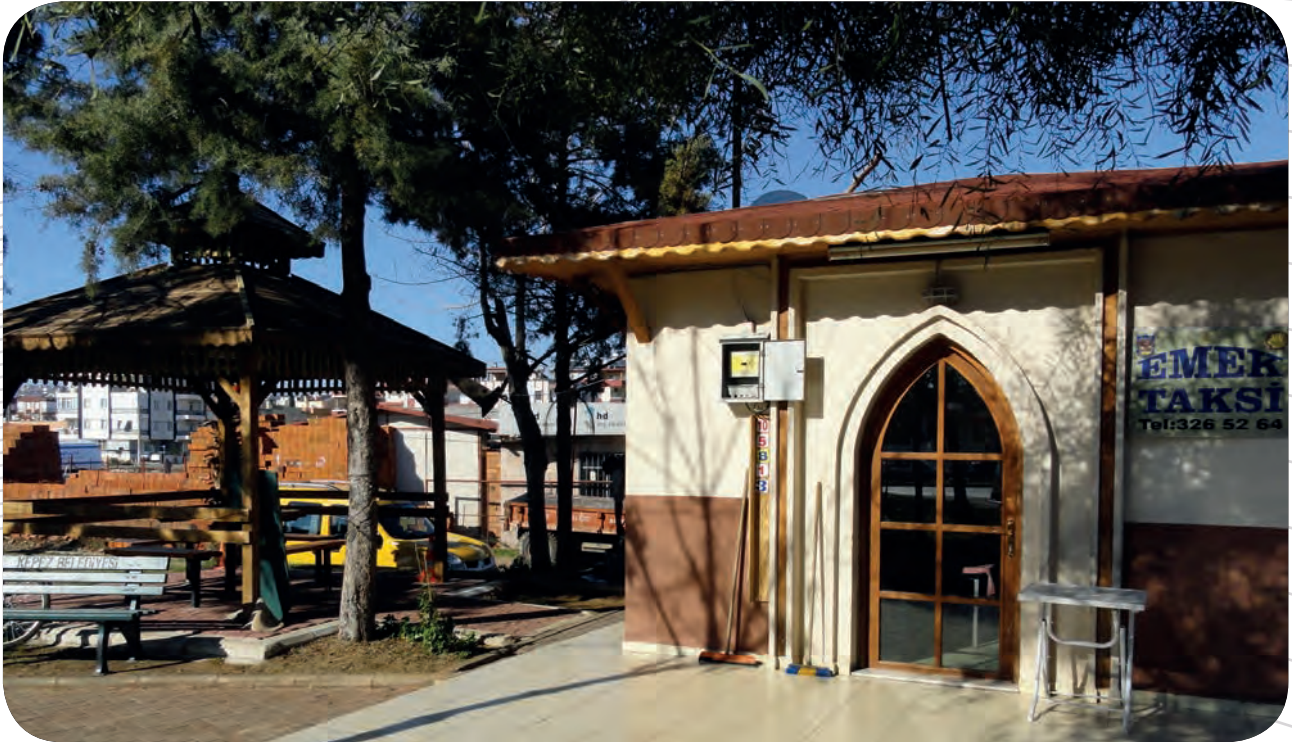
Emek Mah. Emek Taksi Durağında Pergola Montajı Ve Çevre Düzenlemesi Yapıldı
