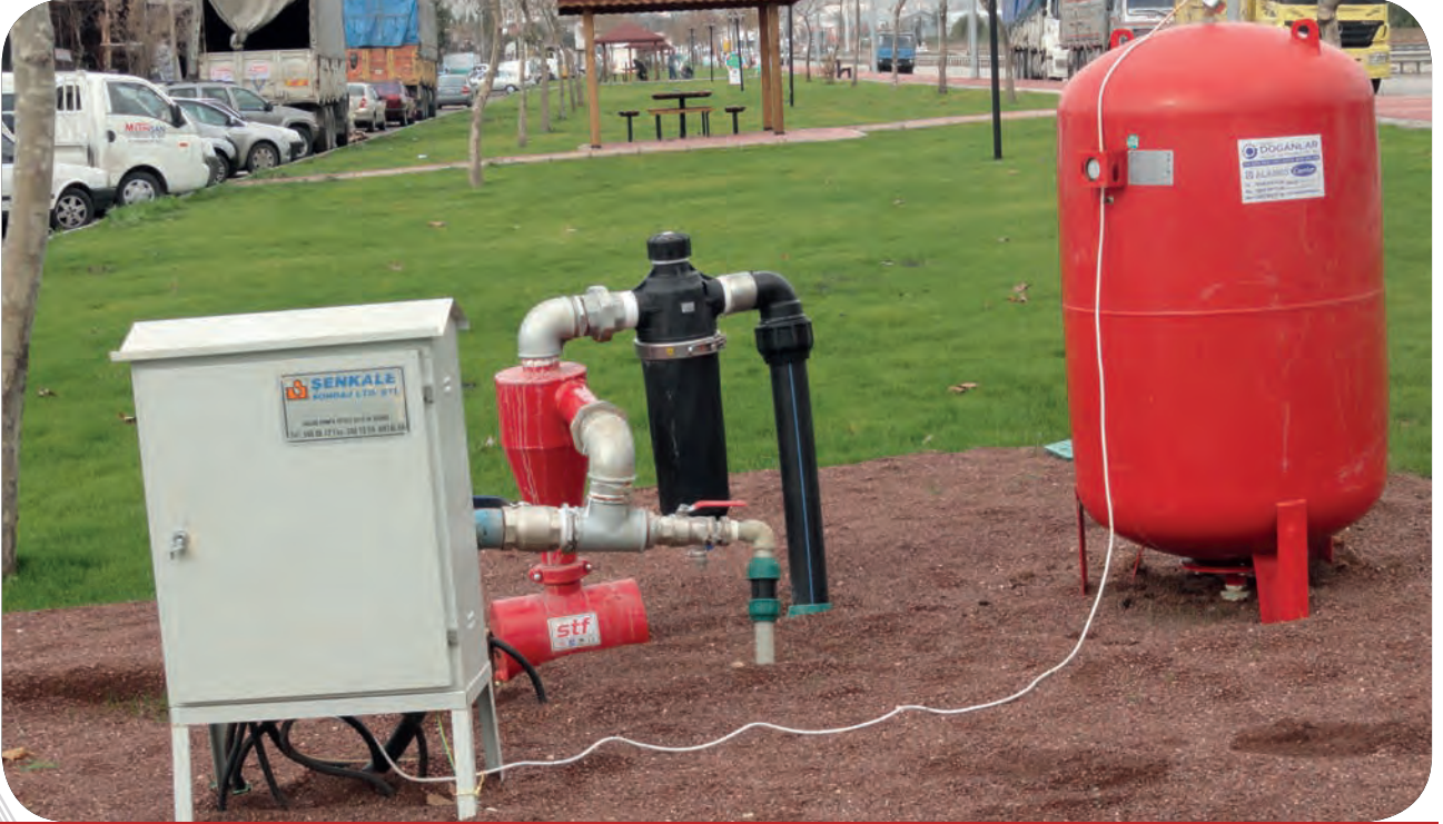
Şafak Mah. 75.Yıl Caddesi Orta Kaldırım Sondajı
