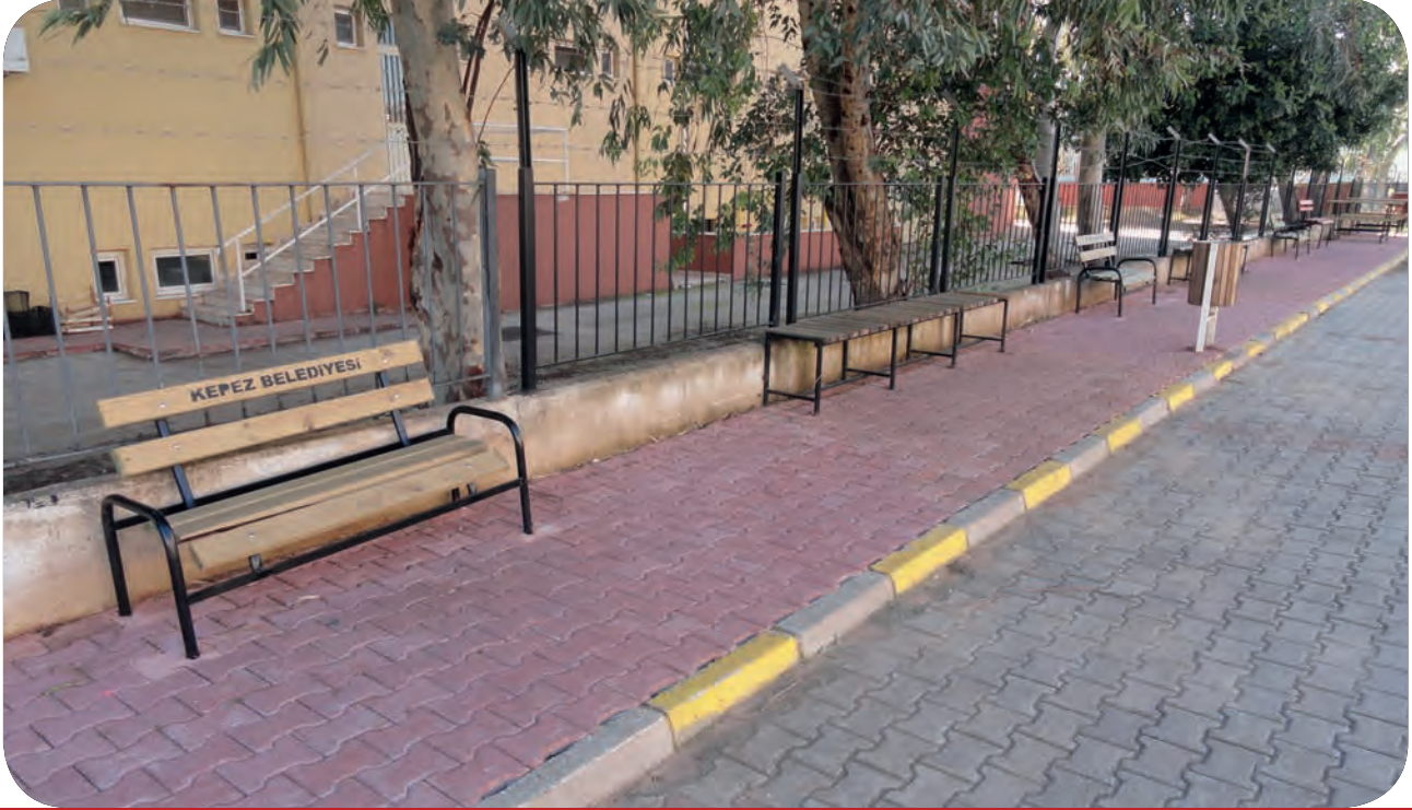
Yeni Mahalle Nevzat Saygan Anadolu Lisesi Bordür Taşı Döşendi
