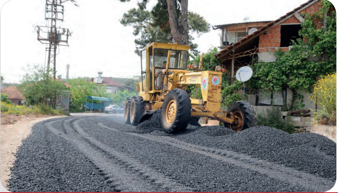
Kepez Mahallesi 3209 Sokak Greyderle Sıcak Asfalt Serme Çalışması
