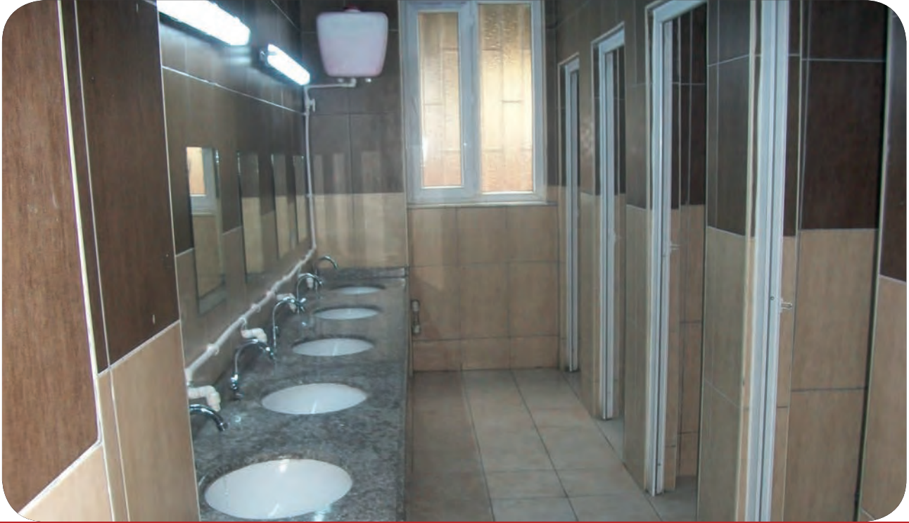
Yenimahalle İlköğretim Okulu Yeni Lavabo Yapımı
