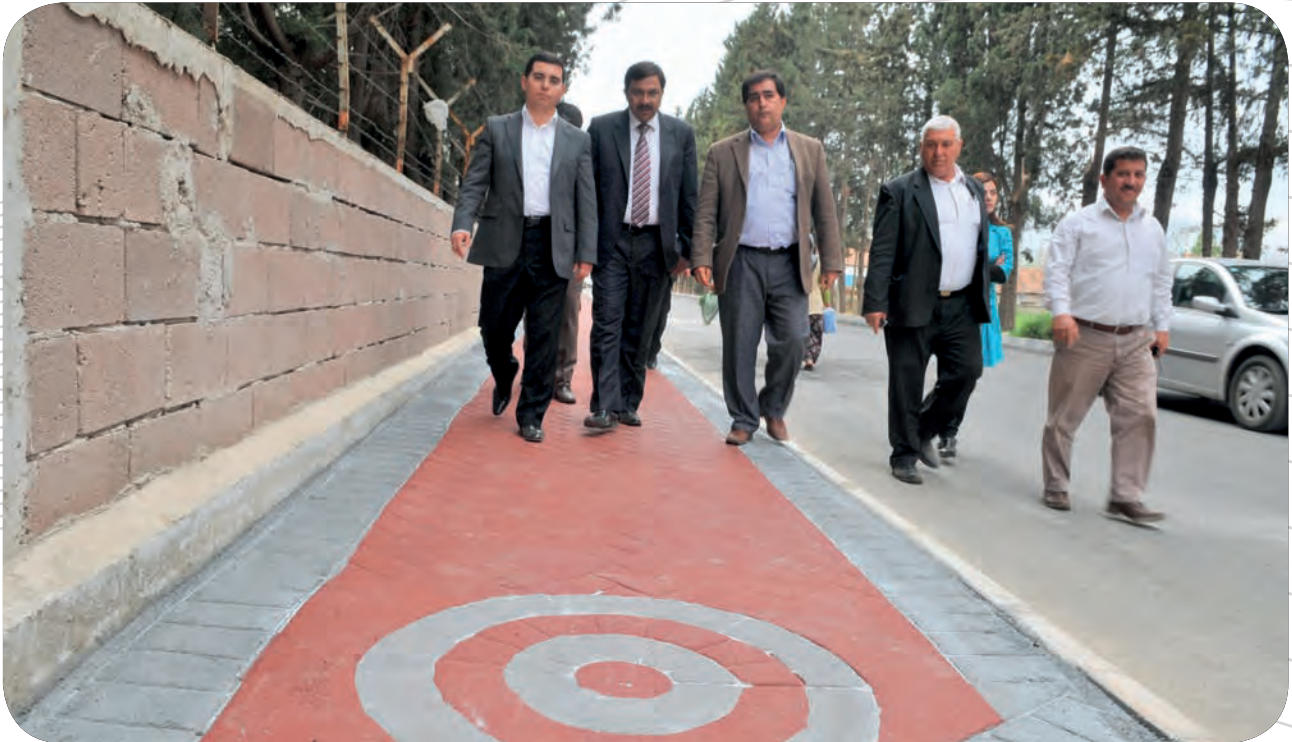
Fabrikalar Mahallesi 3051 Sokak Sıcak Asfalt Kaldırım Çalışması
