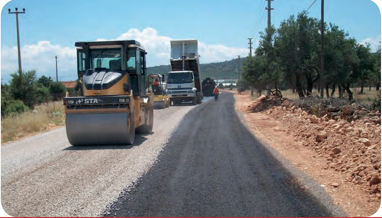
Varsak Altıyayak Mahallesi 17. Cadde Sathi Kaplama Asfalt
