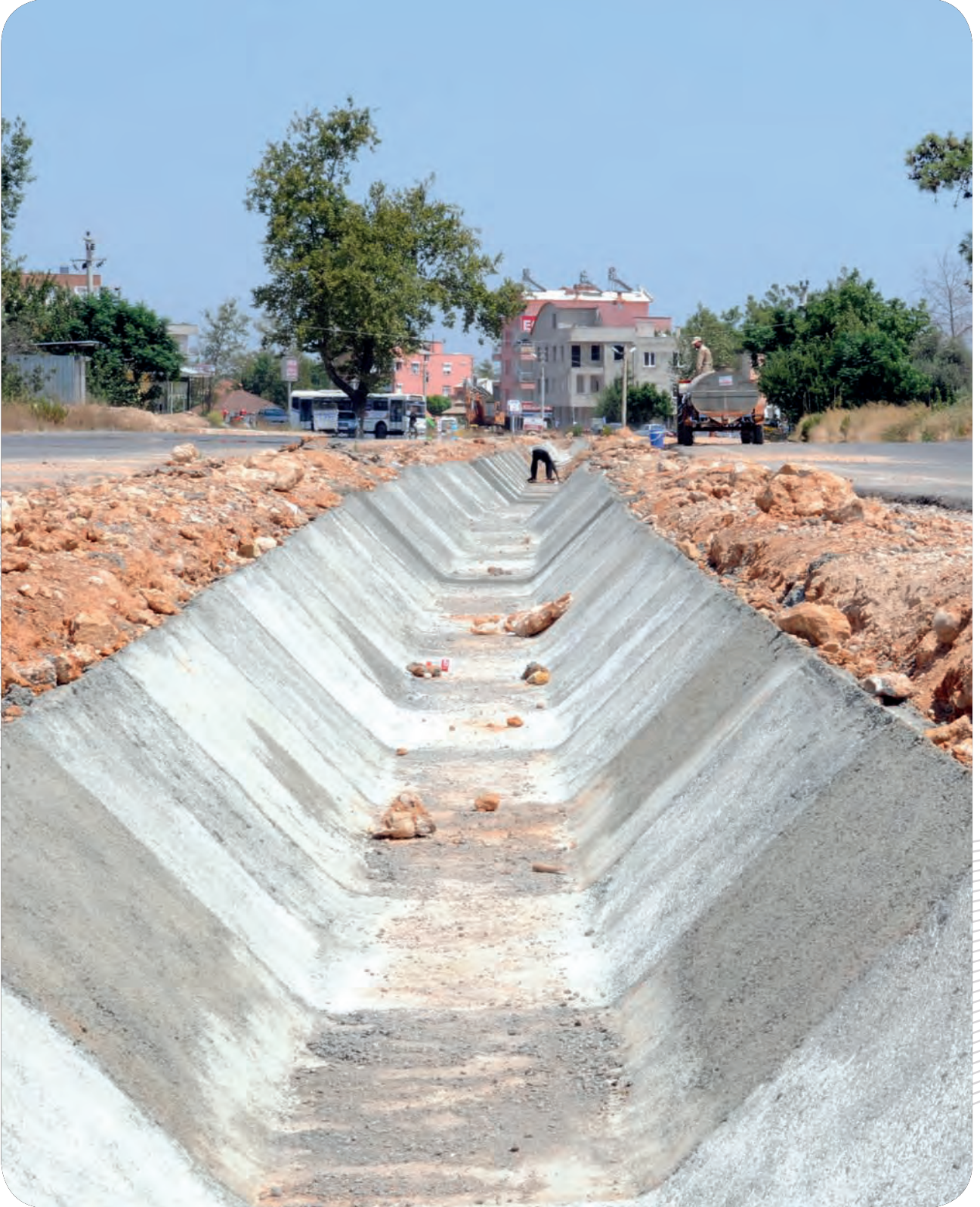
Gazi Mahallesi Trapez Kanal Yapımı
