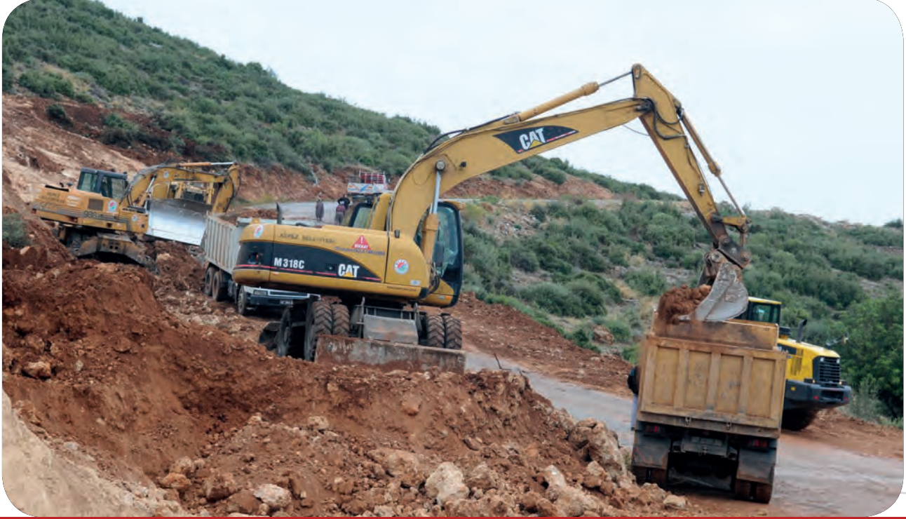
Çankaya Mah. Masadağı 6410 Sokak Yeni Yol Açım Çalışması (Önceki Hali)
