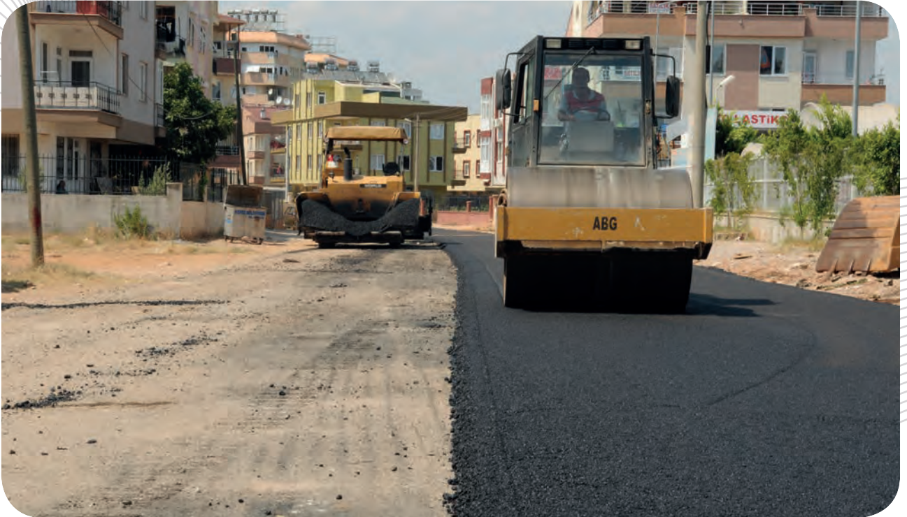
Güneş Mahallesi 6049 Sokak Finişerle Sıcak Asfalt Serme Çalışması
