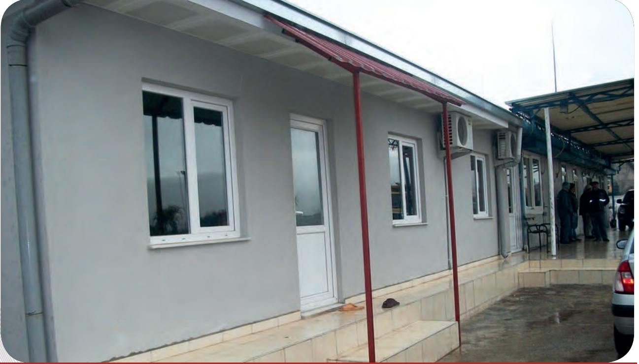
Fen İşleri Müdürlüğü Şantiyesi Ek Hizmet Binası
