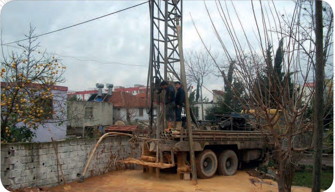
Habibler Mahallesi Yağmur Suyu İçin Sondaj Kuyusu Açımı
