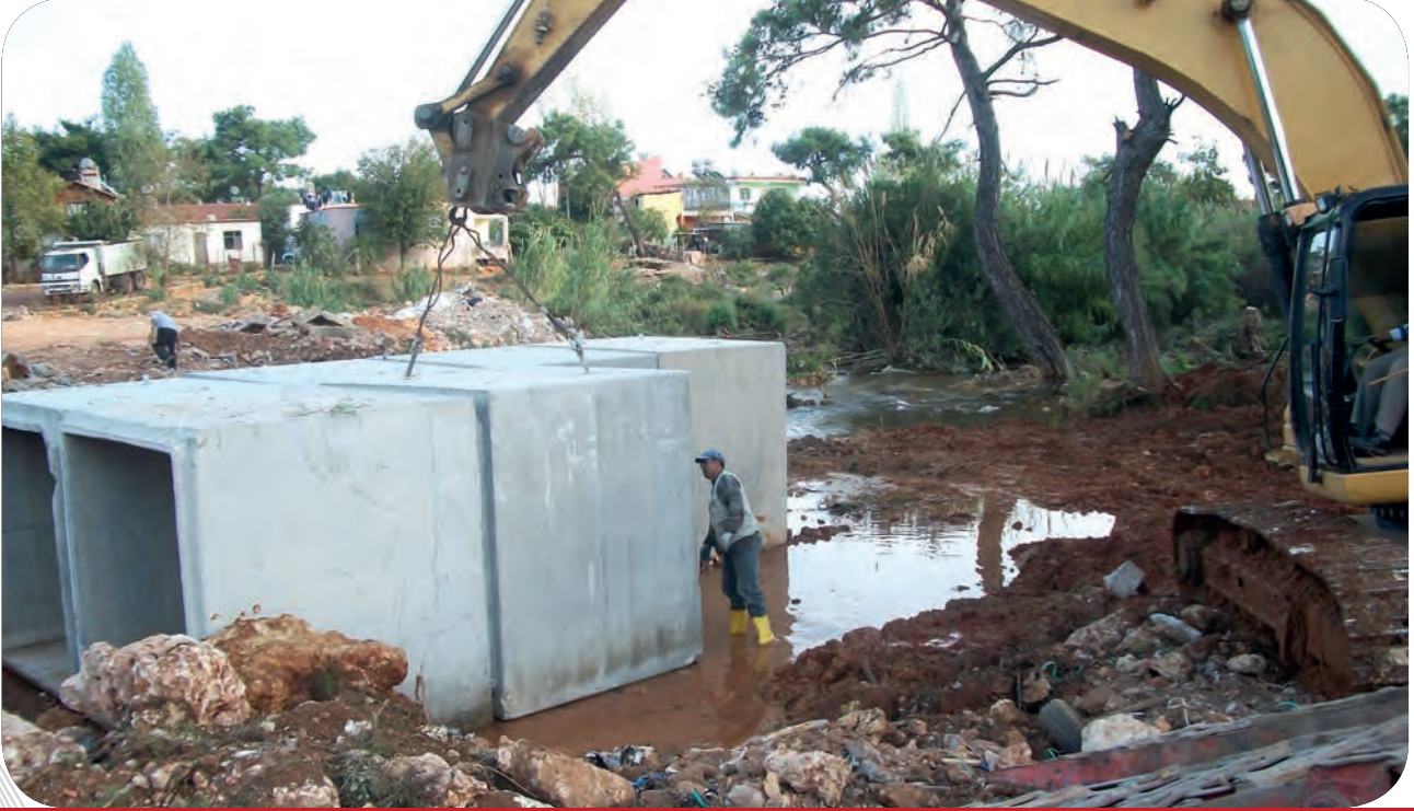
Avni Tolunay Mahallesi Duraliler Mahallesi Menfez Çalışması
