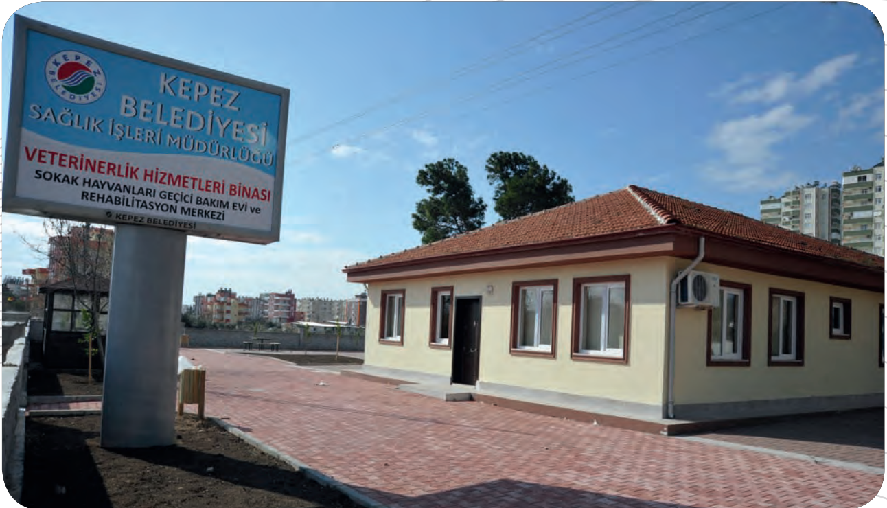
Varsak Karşıyaka Mahallesi Veterinerlik Hizmetleri Binası
