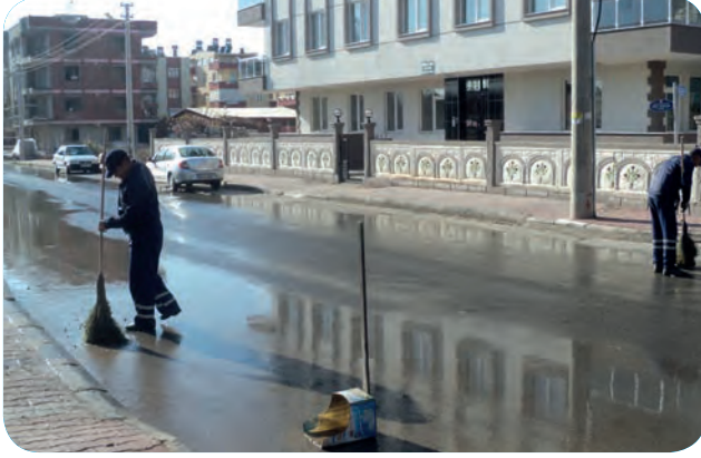
Asfalt ve kaldırım yıkanması
