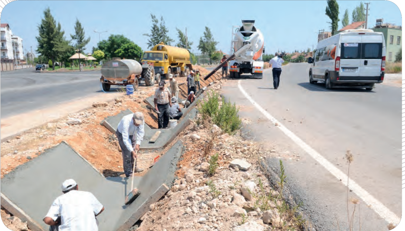
Gazi Mahallesi Trapez Kanal Yapımı
