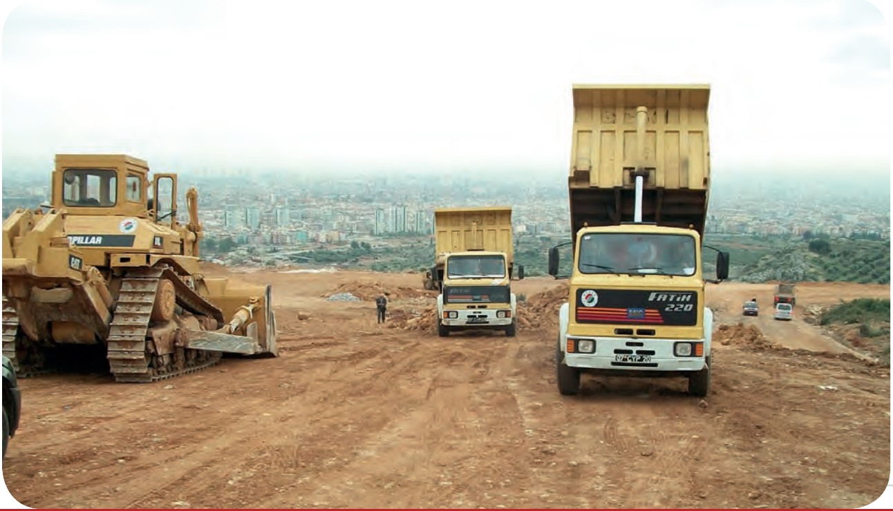
Çankaya Mahallesi Masadağı 6410 Sokak Stabilize Yol Yapım Çalışması
