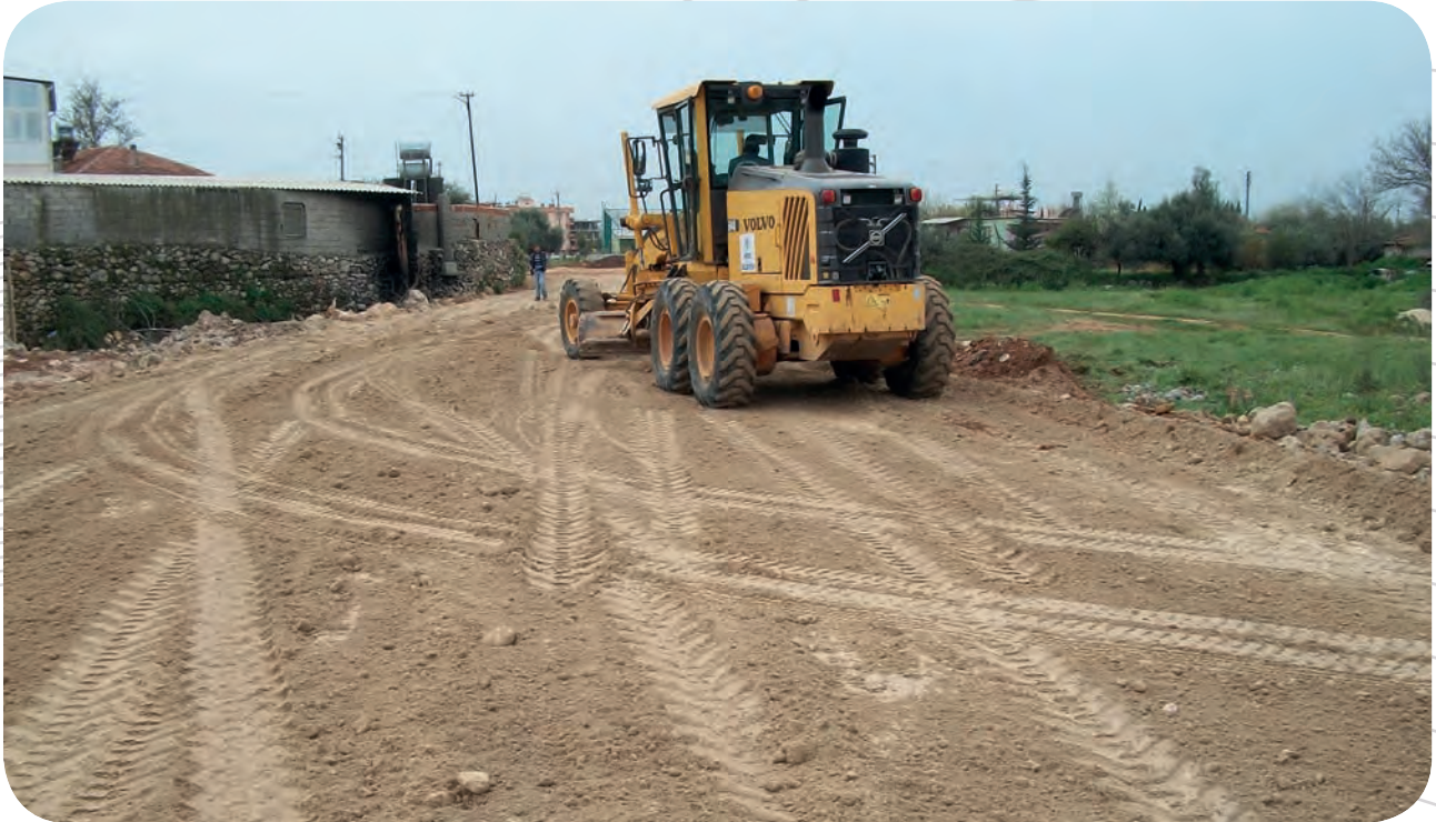
Habibler Mahallesi Yeni Açılan Yolda Stabilize Yol Yapım Çalışması
