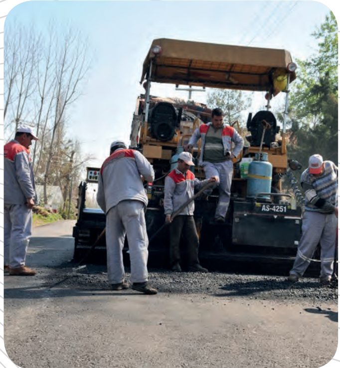
Duraliler Mahallesi Duraliler Caddesi Sıcak Asfalt Serme Çalışması
