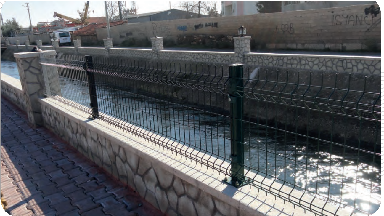
Kanal Boyu Yeni Düzenlenmiş Hali
