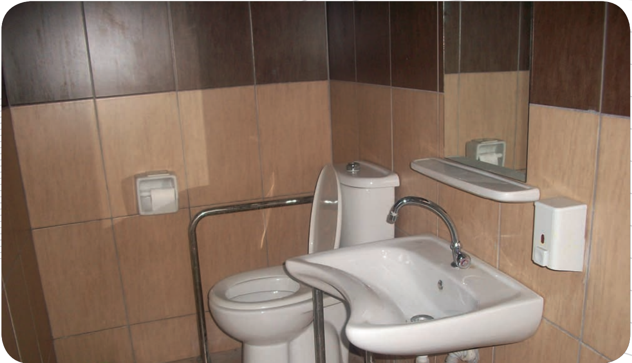
Yenimahalle İlköğretim Okulu Engelli Lavabosu Yapımı
