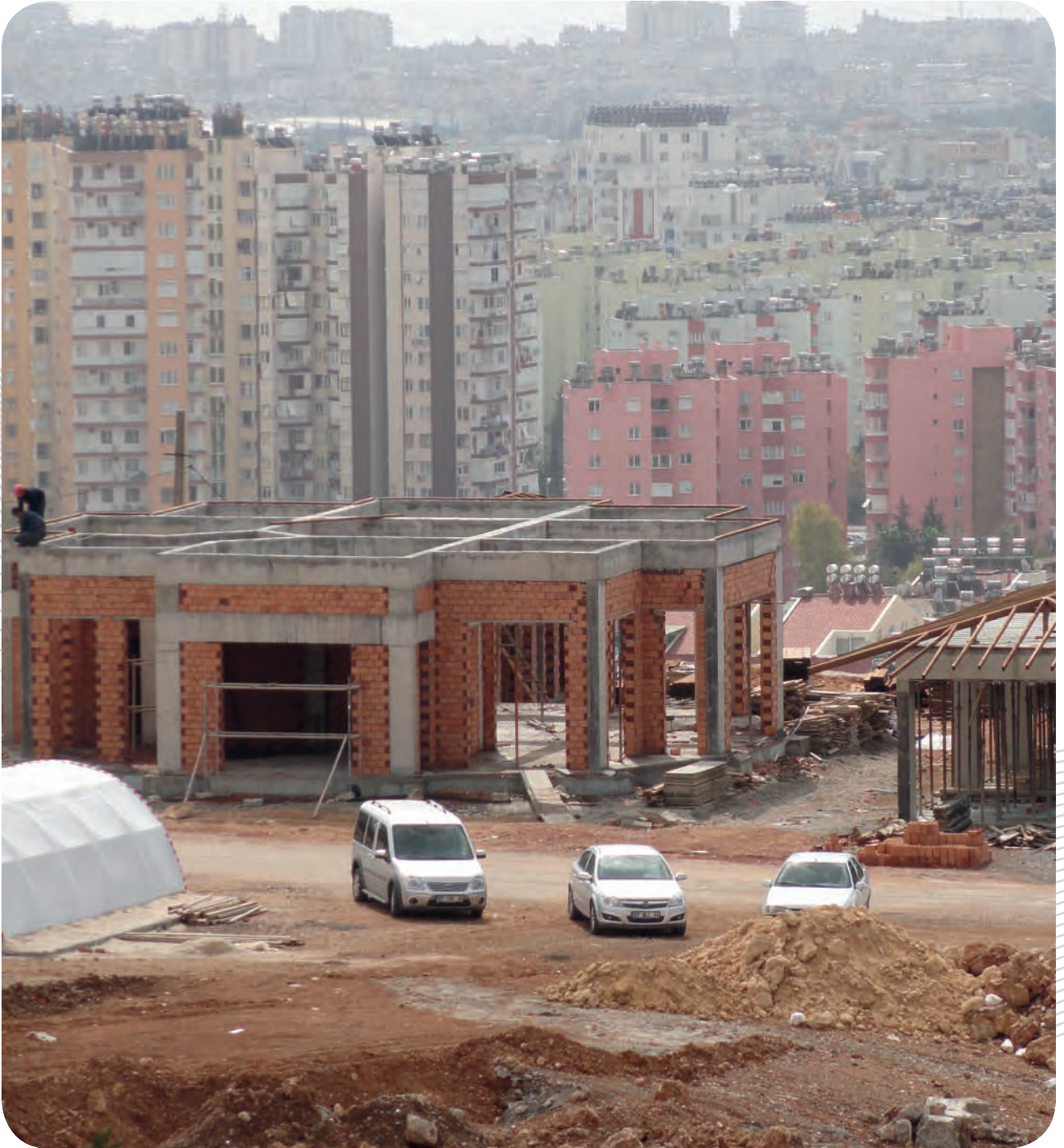
Yörük Parkı İnşaat Çalışmaları Sürdürülmektedir
