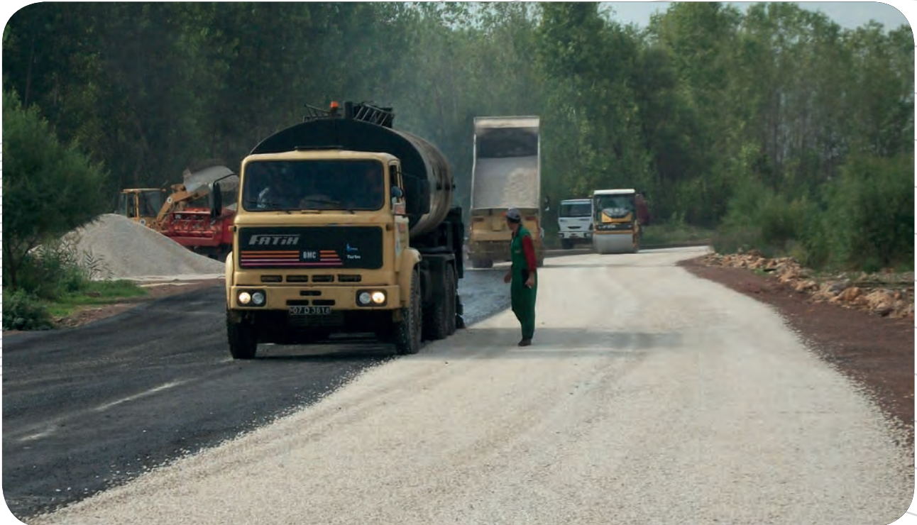
Varsak Karşıyaka Mahallesi Kındıra Yolu Sathi Kaplama Asfalt
