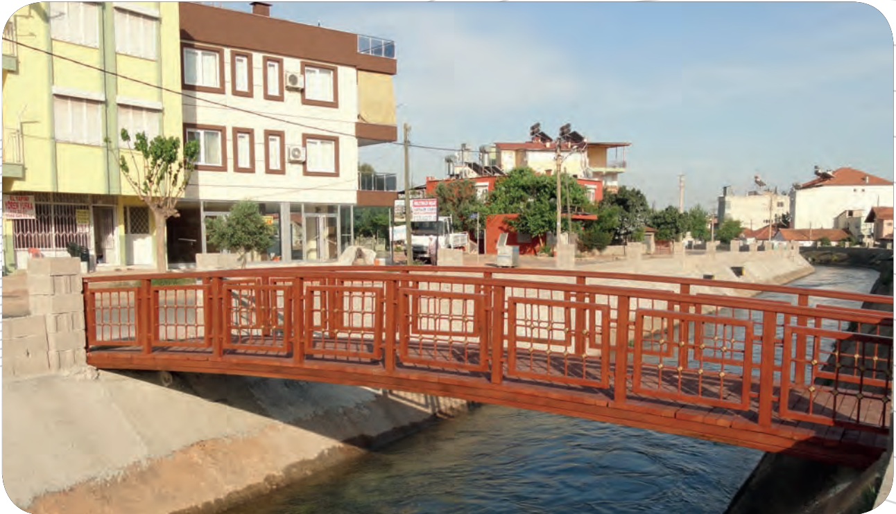
15Adet Yeni Köprü Yapılmıştır.
