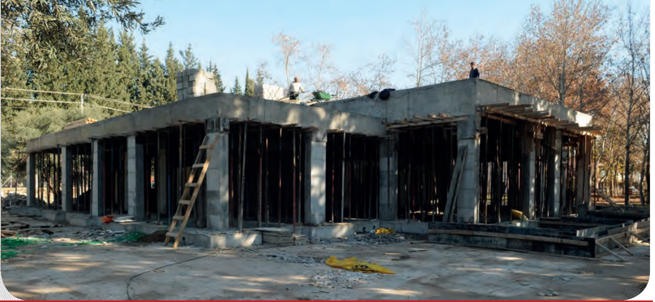
Butik Kültür Merkezi İnşaatı Devam Etmektedir
