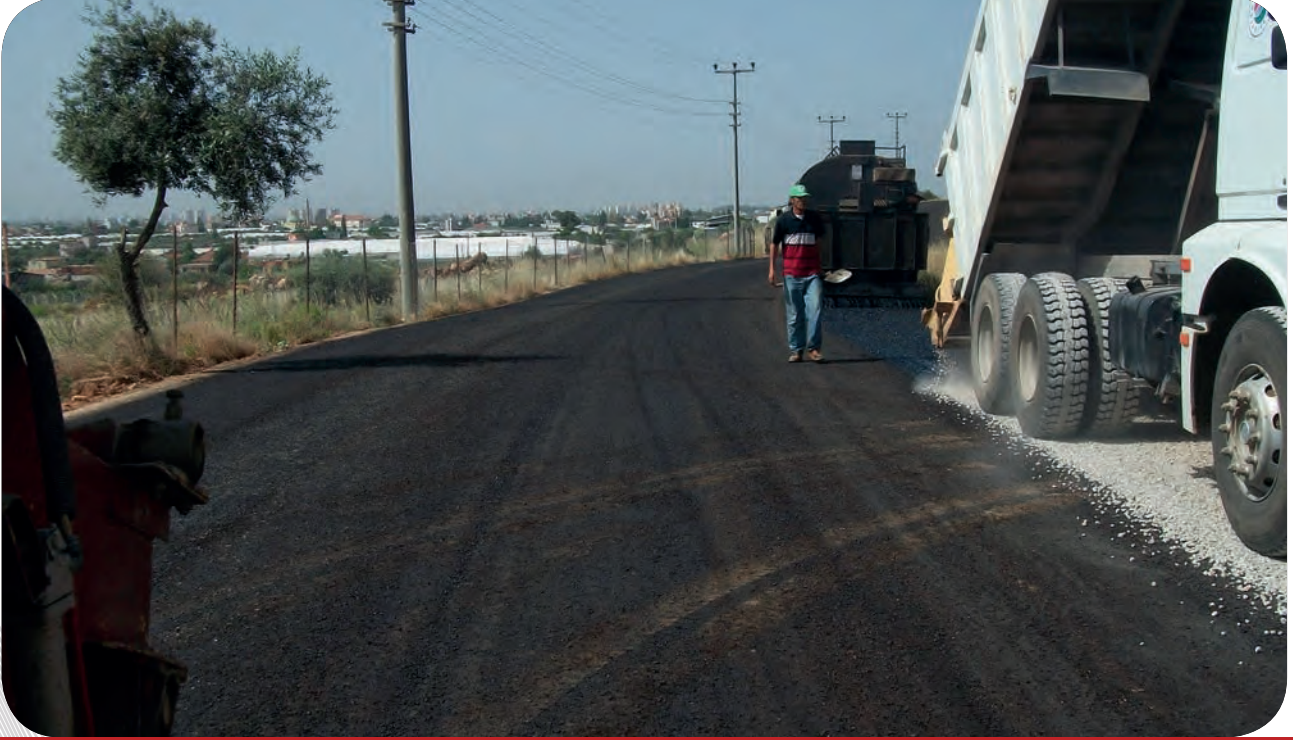
Varsak Altıayak Mahallesi Ayanoğlu Caddesi Sathi Kaplama Asfalt Dökümü
