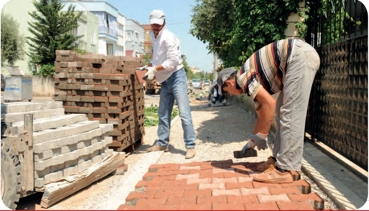
Karşıyaka Mahallesi 3938 Sokak Prefabrik Beton Kaldırım Çalışması
