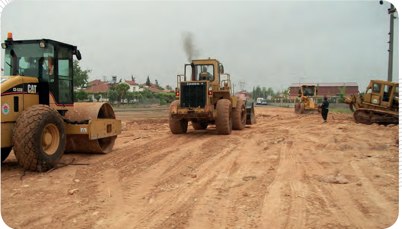
Hüsnü Karakaş Mahallesi Yeni Açılan Yolda Stabilize Yol Yapım Çalışması
