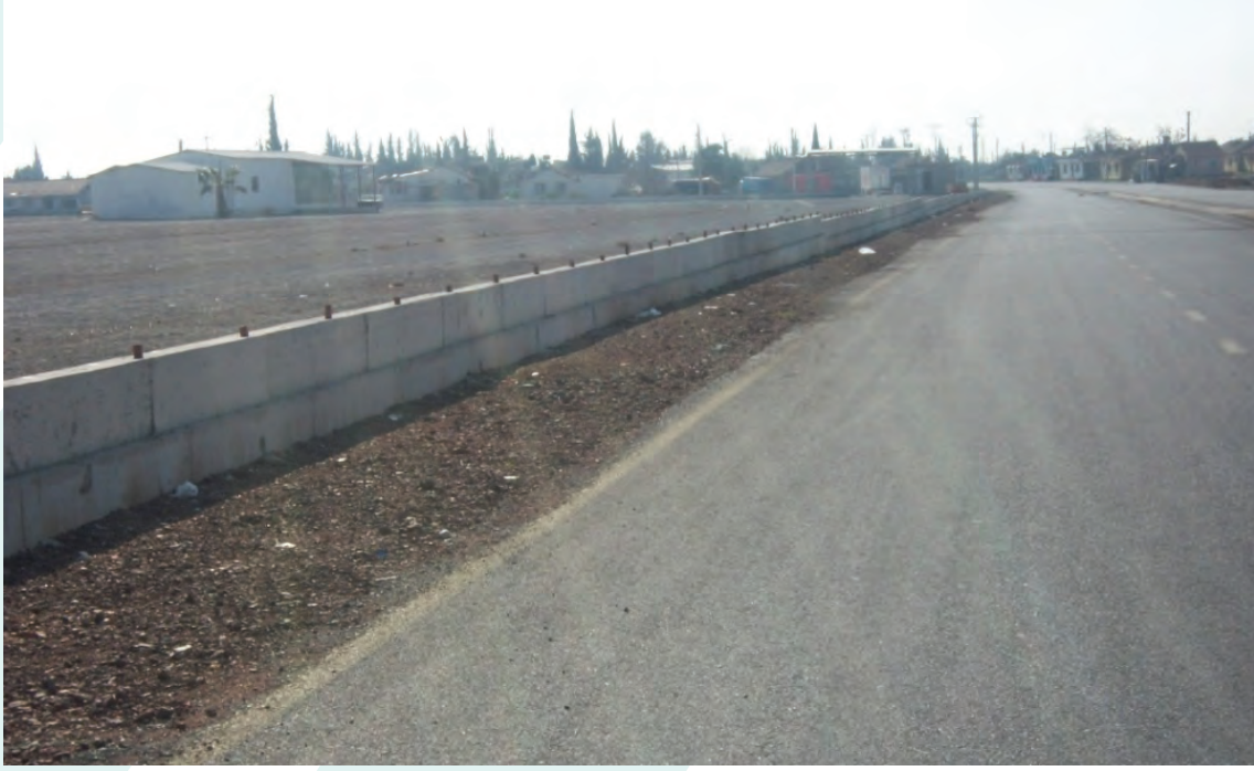
❖ Baraj Mahallesi Araç Pazarı Çevre Duvarı Yapılması
