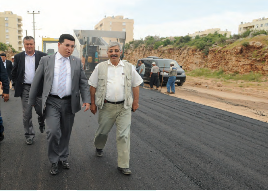
❖ Çankaya Mahallesi Sıcak Asfalt Serme Çalışması
