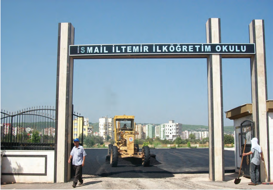
❖ Greyderle Sıcak Asfalt Serme Çalışması
