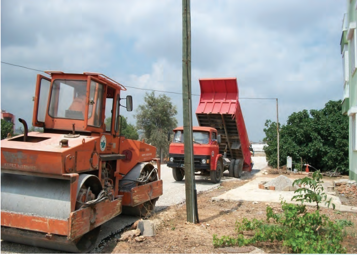
❖ Sathi Kaplama Asfalt Döküm ve Sıkıştırma Çalışması
