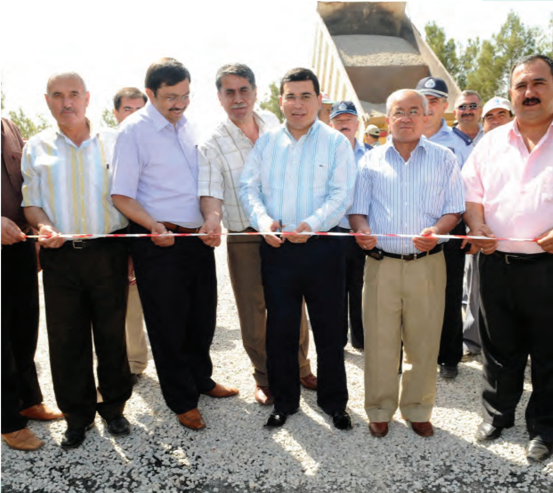
❖ Sathi Kaplama Asfalt İçin Asfalt Atım Çalışması;
