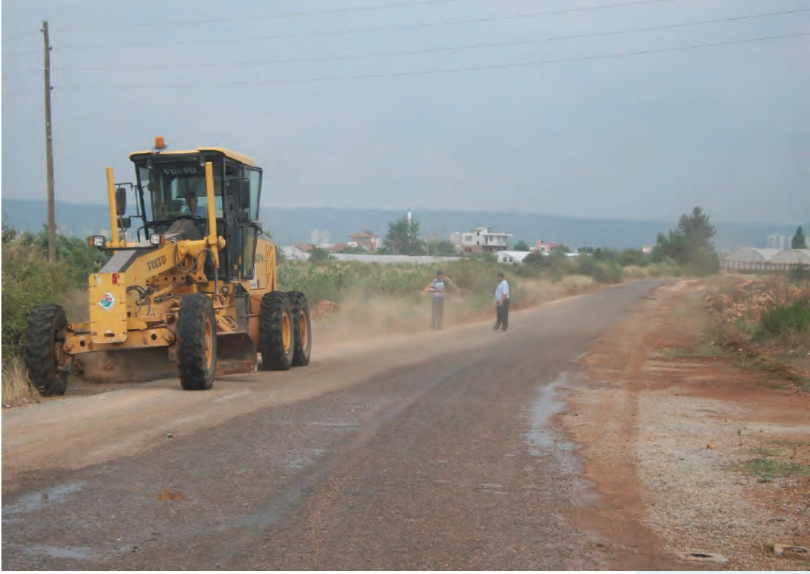
❖ Yol Yapım Çalışmaları
