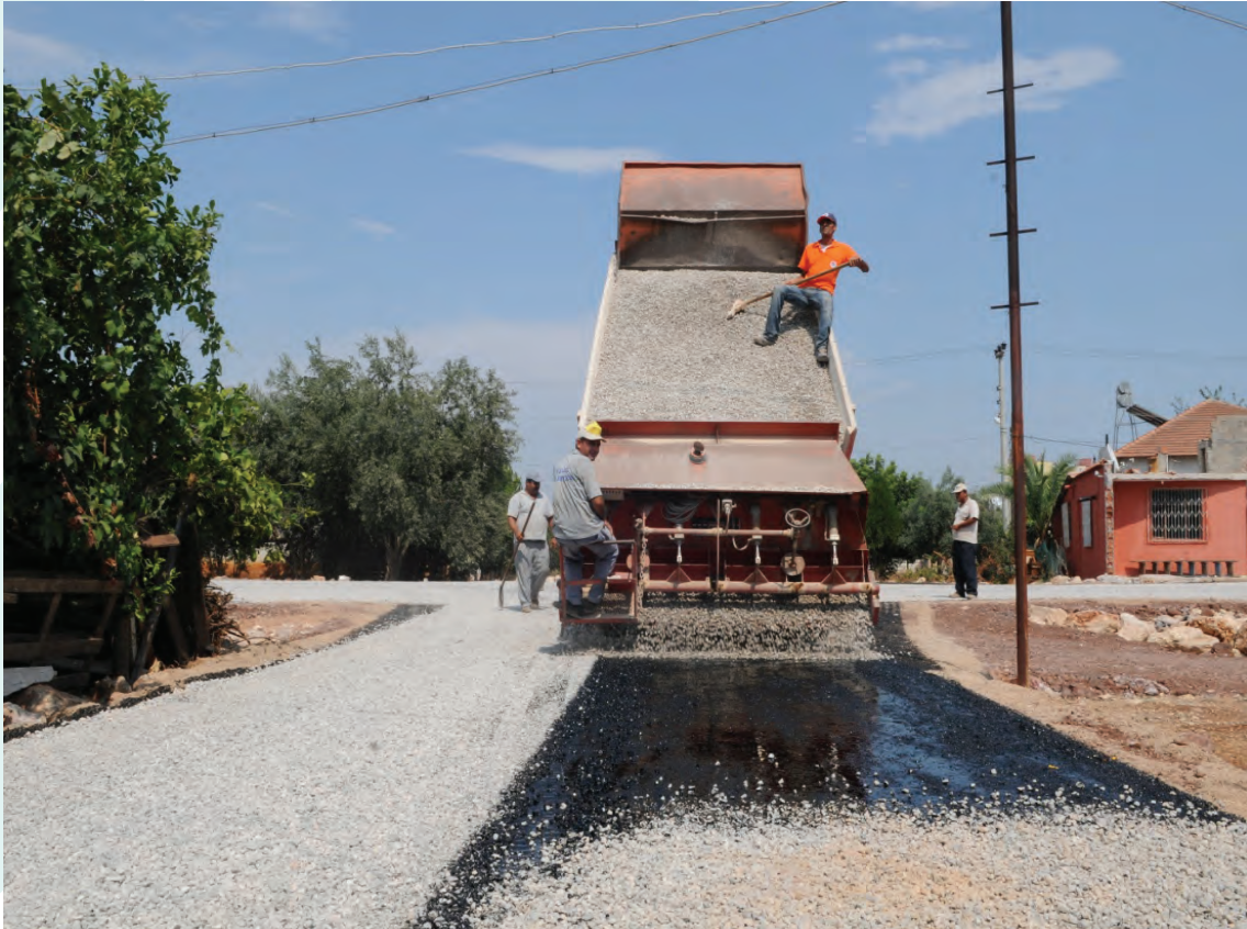
❖ Sathi Kaplama Asfalt Serim Çalışması
