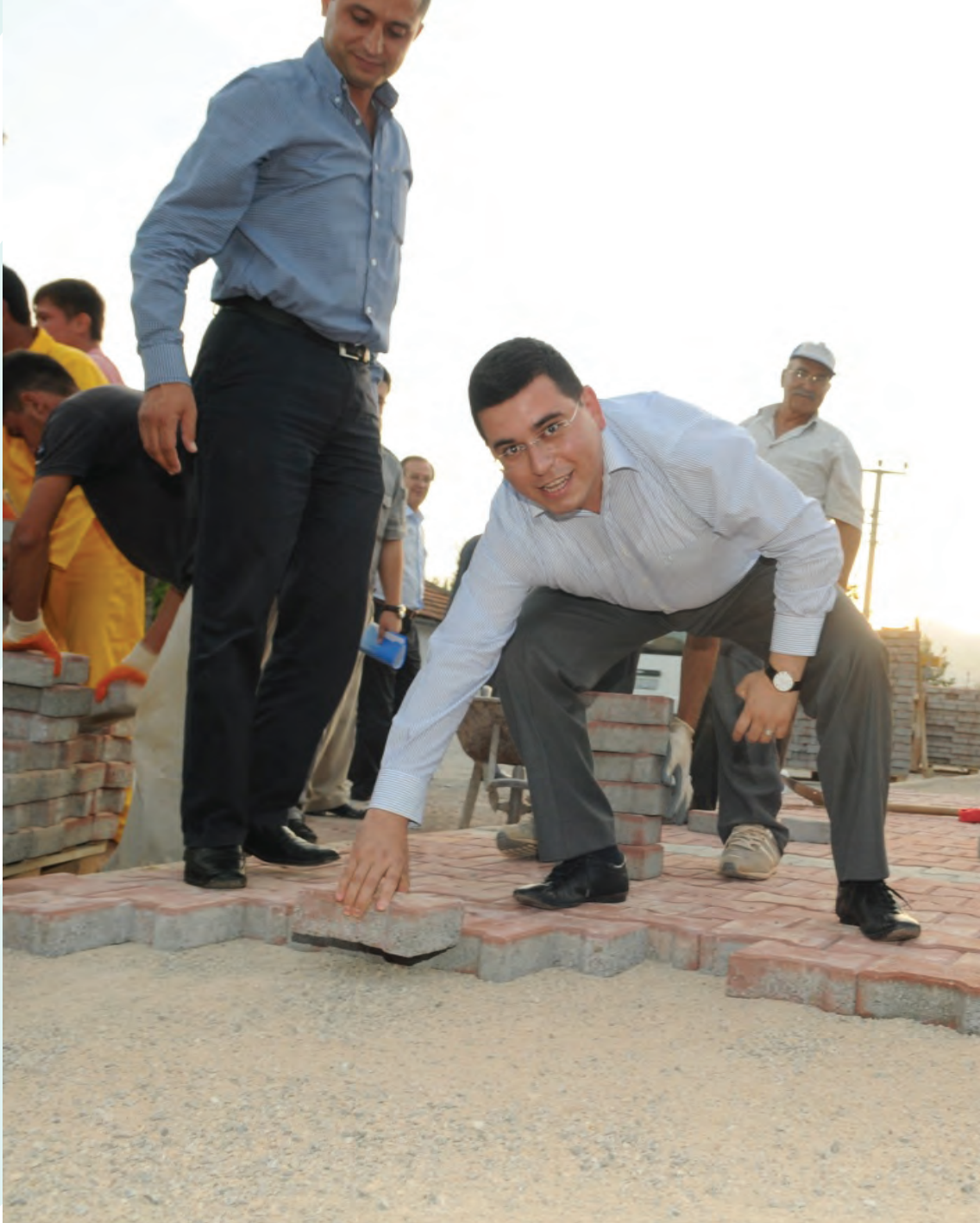
❖ Fatih Mahallesi Prefabrik Beton Kaldırım Yapım Çalışması
