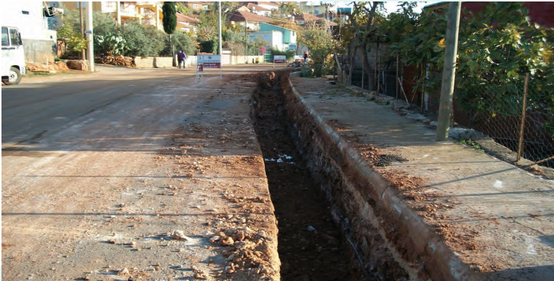
❖ Yağmur Suyu Drenaj Çalışması
