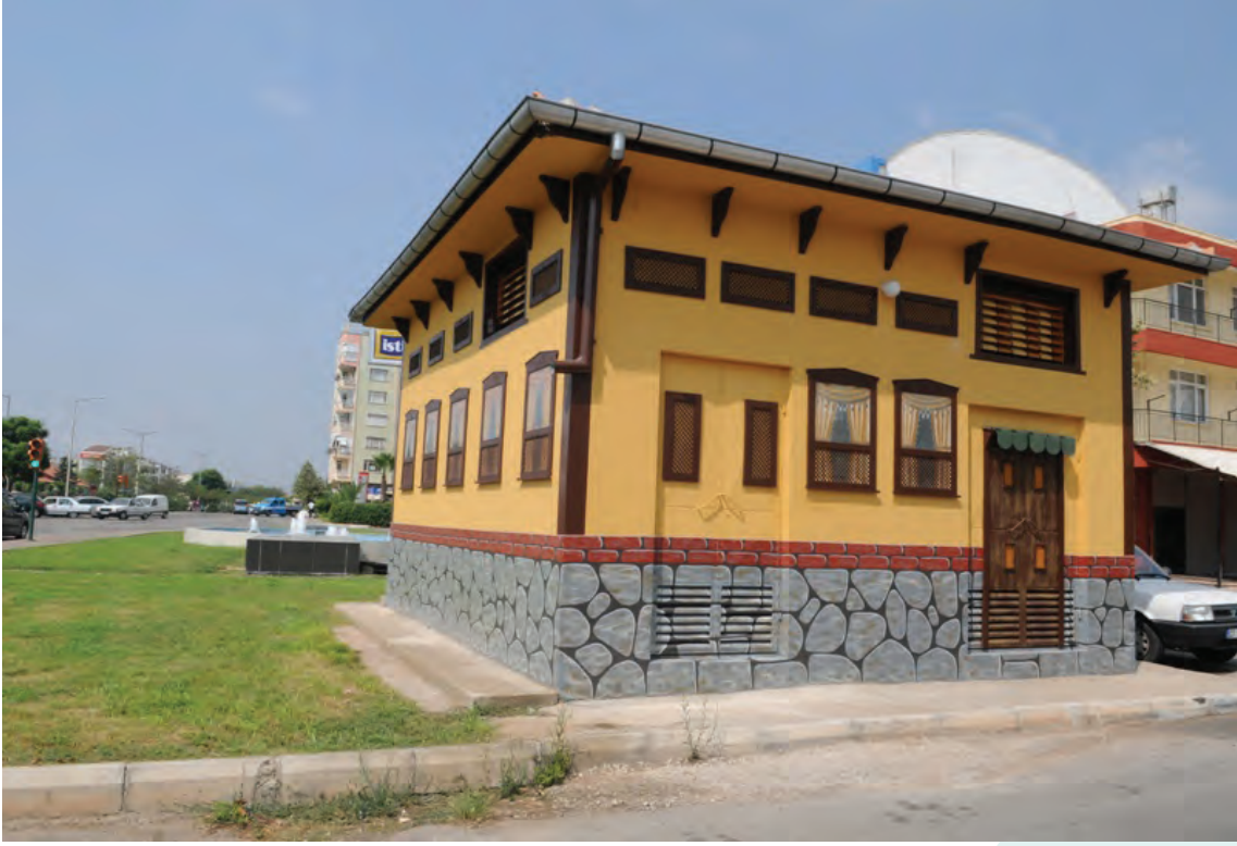
❖ Yükseliş Mahallesi Trafo Çalışması
