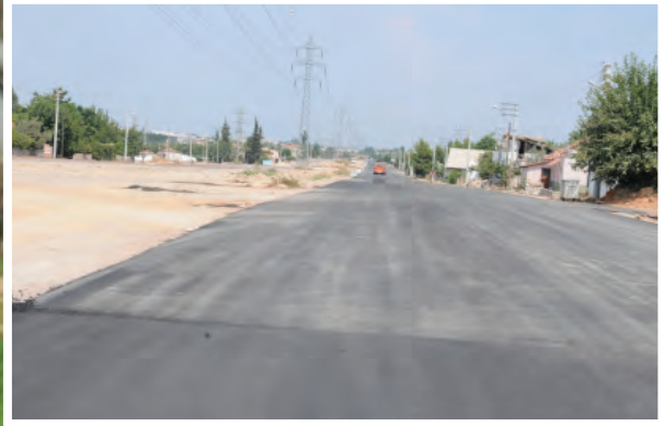
❖ Habibler Mahallesi Muammer Aksoy Caddesi Sıcak Asfalt Çalışması
