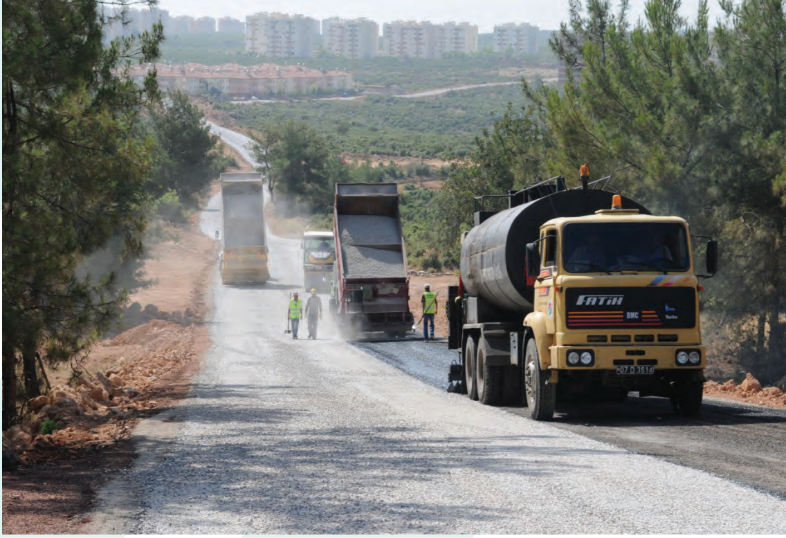
❖ Sathi Kaplama Asfalt Serme Çalışması
