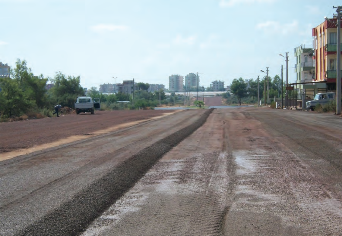
❖ Yol Yapım Çalışmaları
