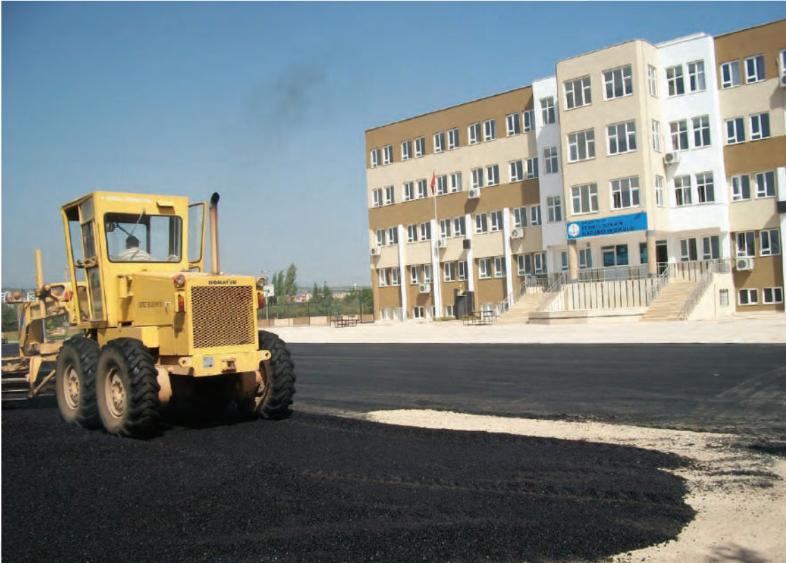
❖ İsmail İltemir İlköğretim Okulu Bahçesine Greyderle Sıcak Asfalt Serim Çalışması
