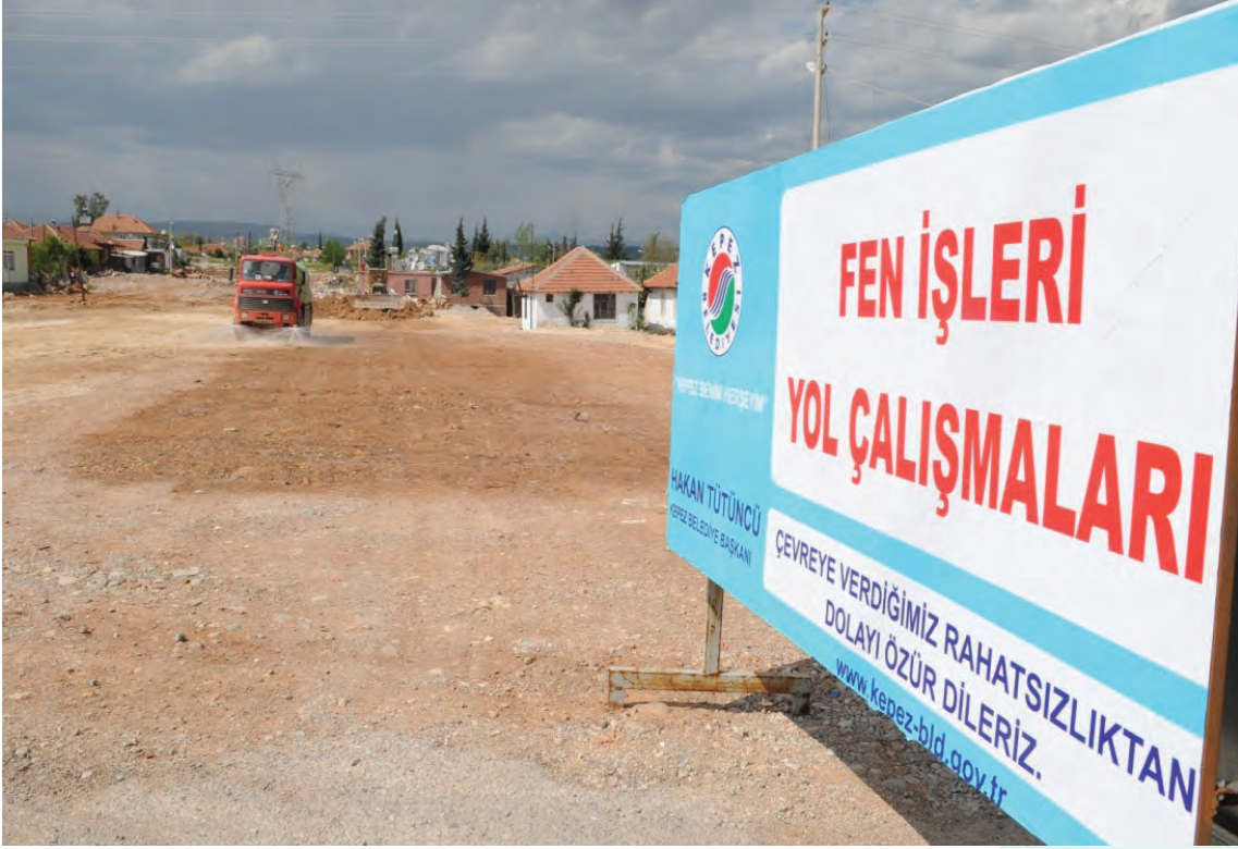
❖ Gazi Mahallesi Stabilize Yol Yapım Çalışması
