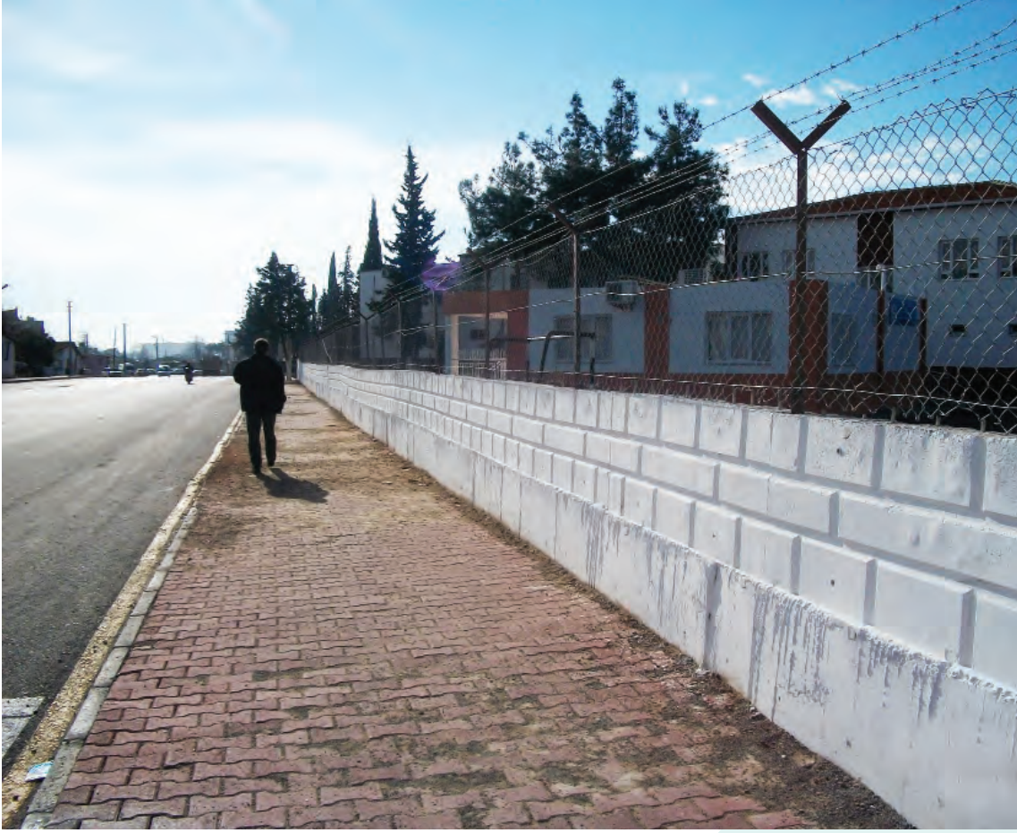
❖ Ali Rıza Altıntaş İlköğretim Okulu Çevre Duvarı Yapılması
