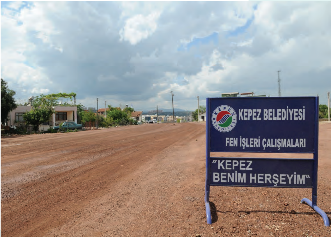
❖ Gazi Mahallesi Stabilize Yol Yapım Çalışması
