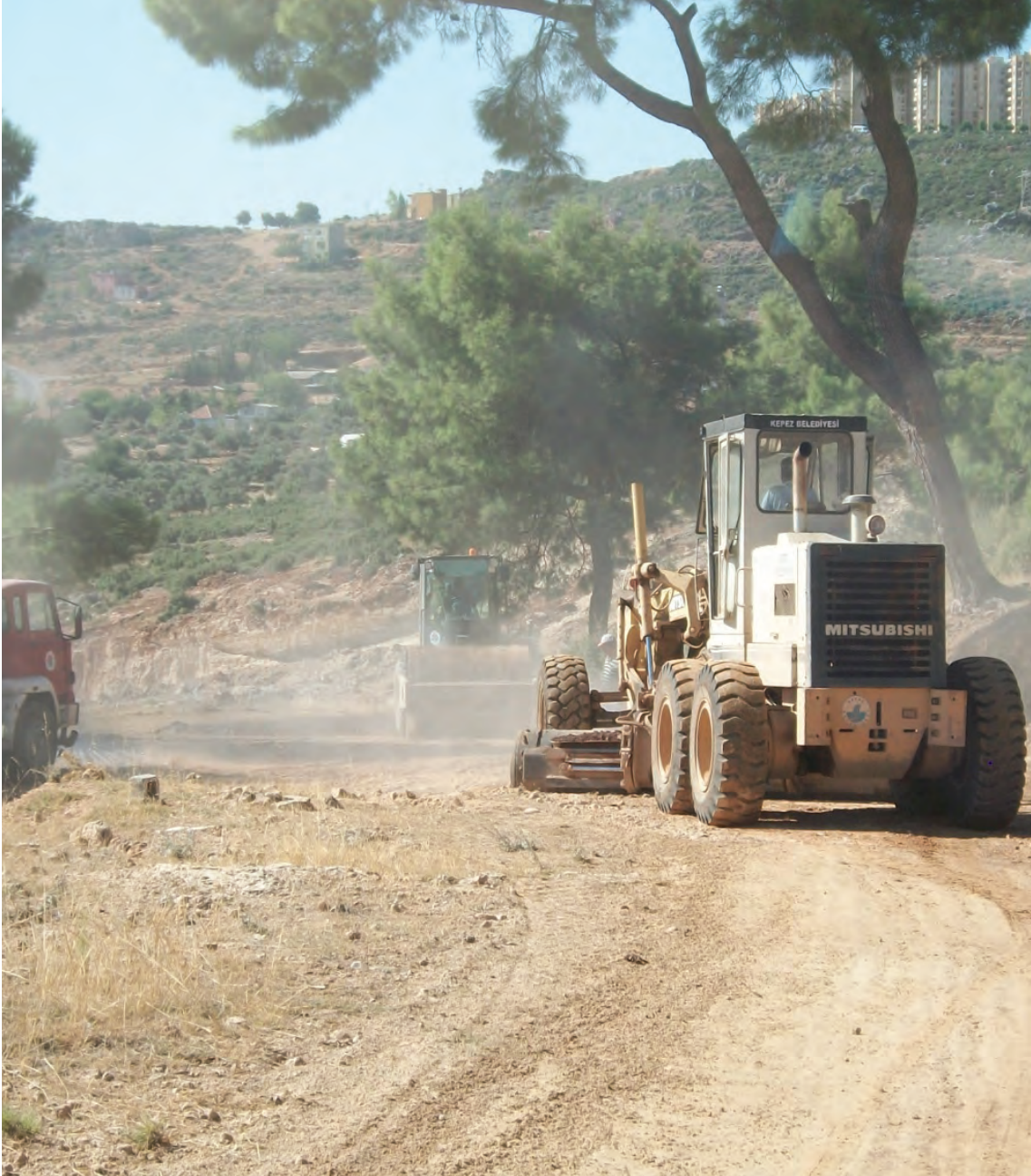
❖ Yol Yapım Tesviye Genişletme ve sıkıştırma çalışması
