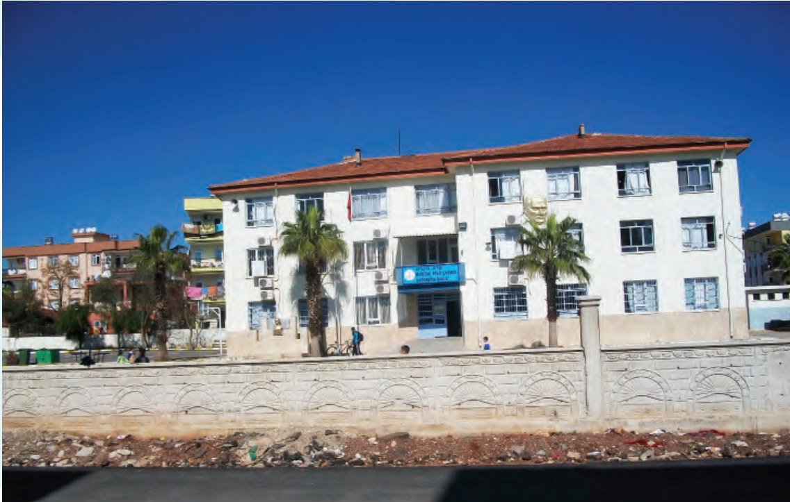
❖ Maraşal Fevzi Çakmak İlköğretim Okulu Çevre Duvarı Yapılması
