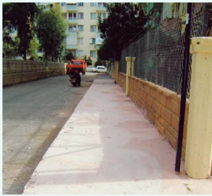
3350 m 2 beton kaldırım döşendi
