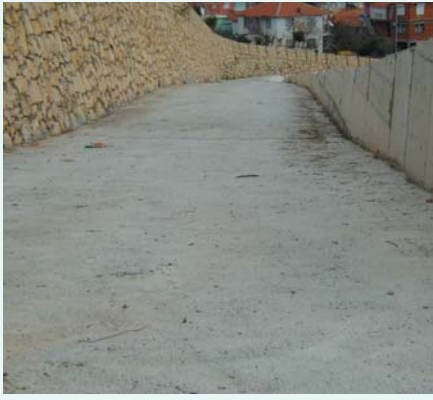
1650 m 2 Beton Yol Yapıldı.
