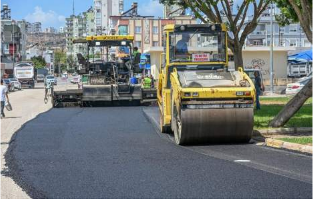
Kuzeyyaka Mahallesi Asfalt Çalışması
