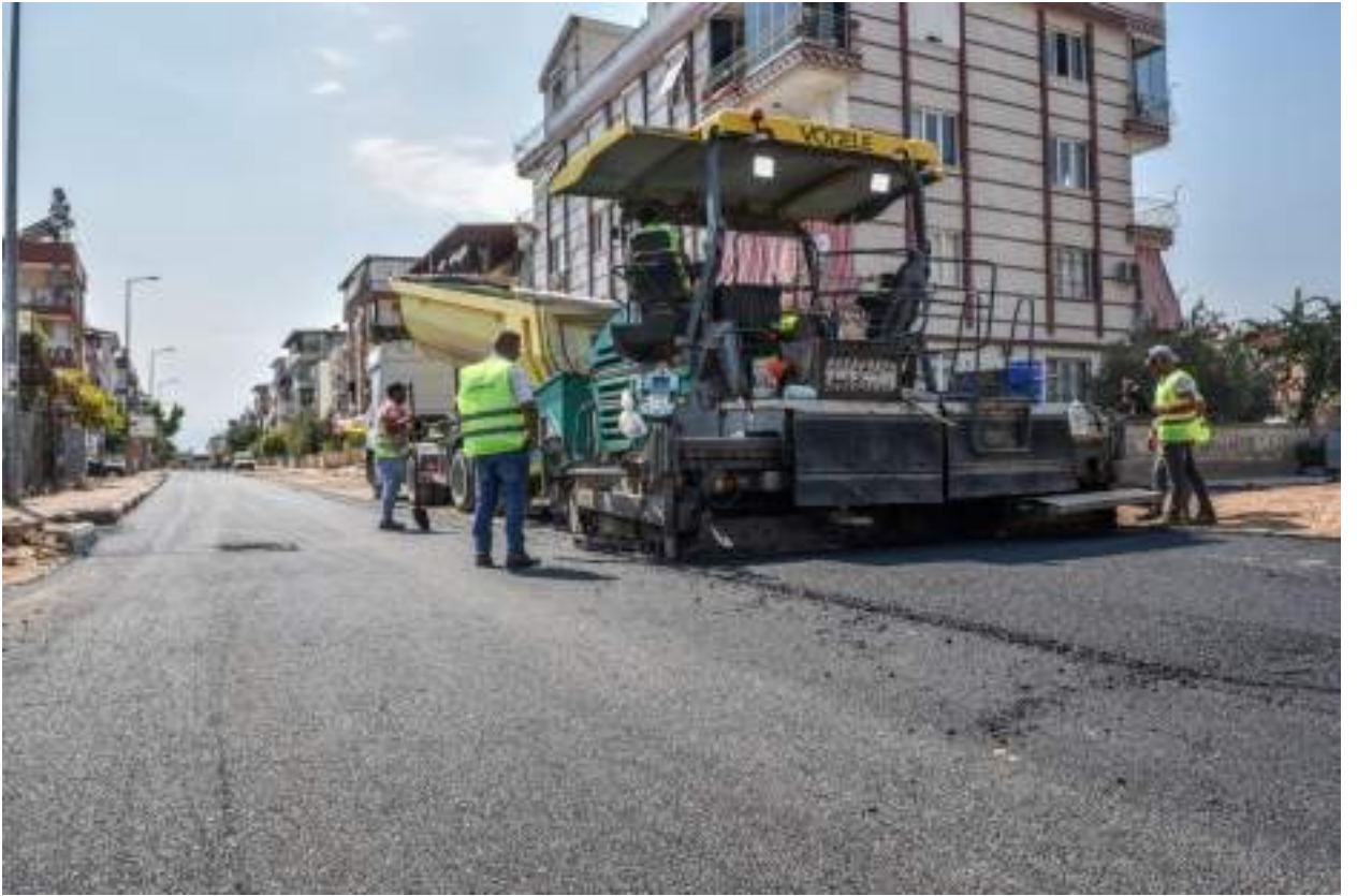
Emek Mahallesi Asfalt Çalışması
