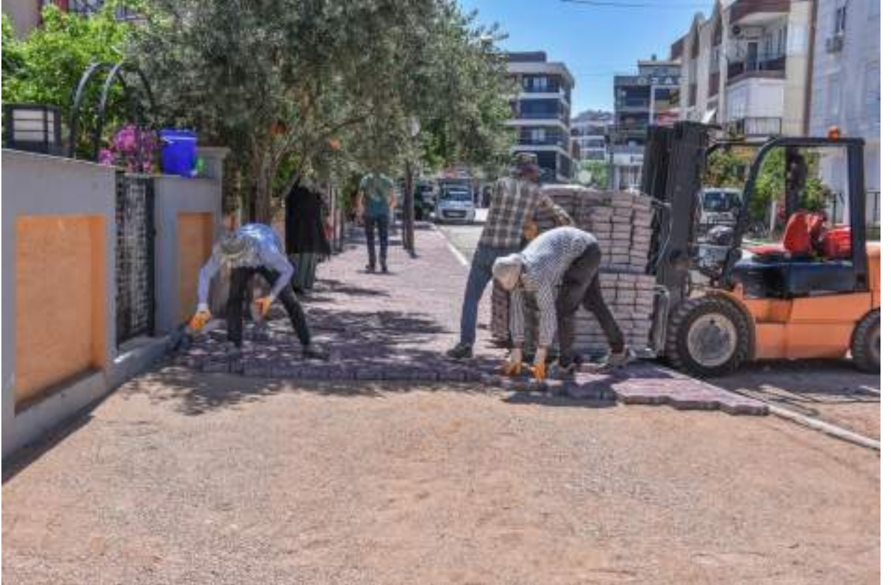
Ayanoğlu Mahallesi Kaldırım Çalışması
