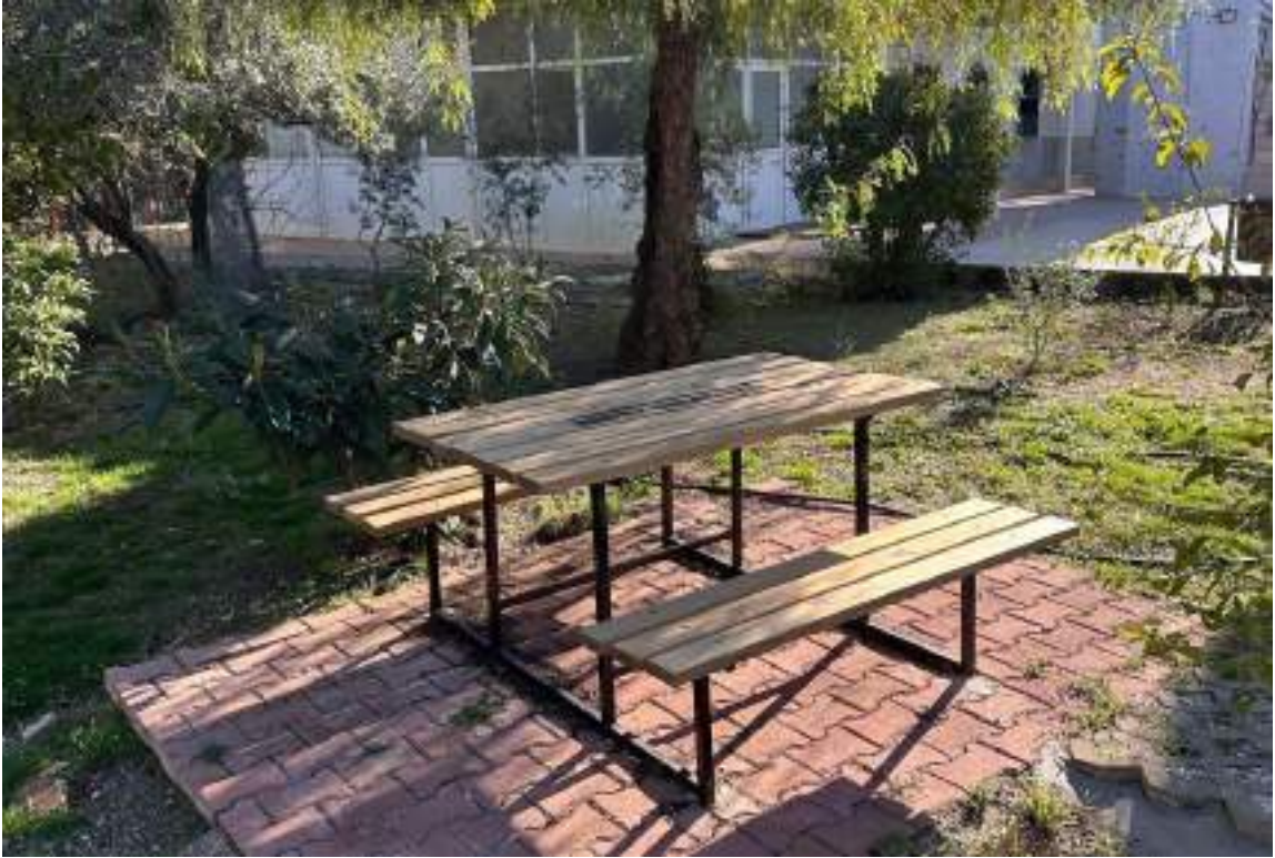
Duacı Mahallesi Duacı Cami Çevre Bordür, Parke Taşı ve Masa Montaj Çalışması
