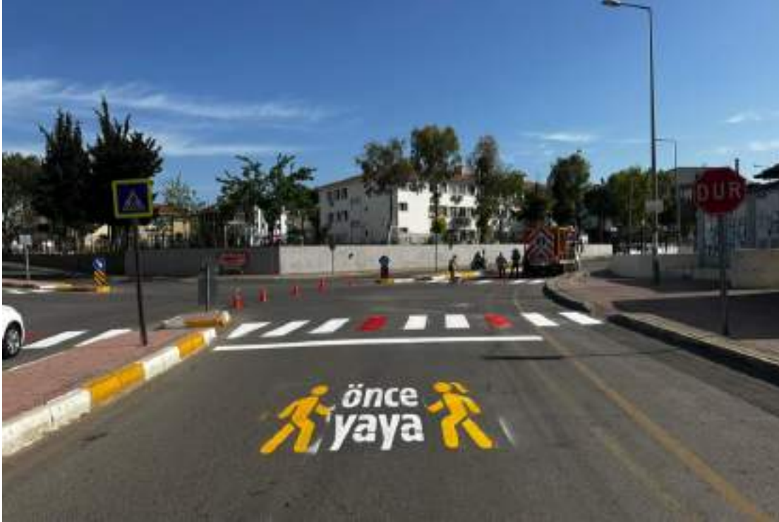
Kültür Mahallesi Yol Çizgi Çalışması
