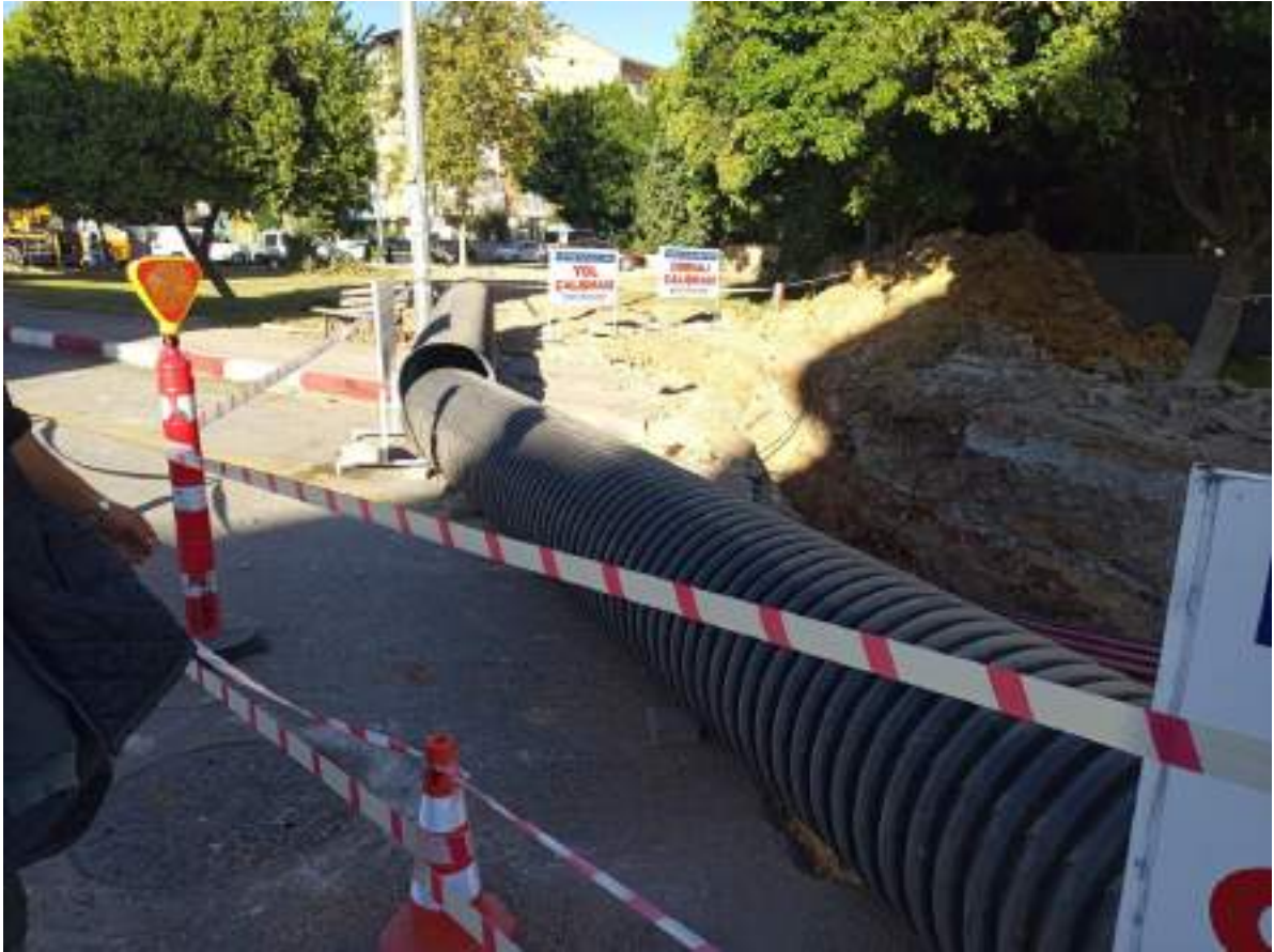
Teoman Paşa Mahallesi Menfez Çalışması
