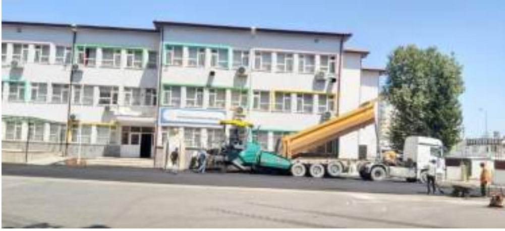
Ayanoğlu Mahallesi Ruhi Göksoy Ortaokulu Bahçe Asfalt Dökümü
