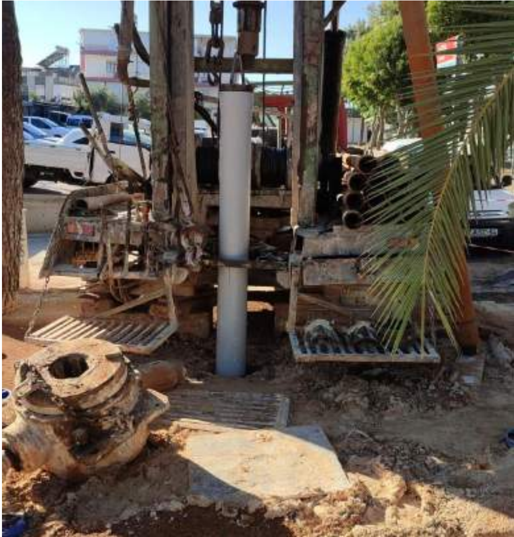
Kanal Mahallesi Sakarya Bulvarı-Halide Edip Caddesi Kesişimi Park Sondaj Kuyusu Açılması
