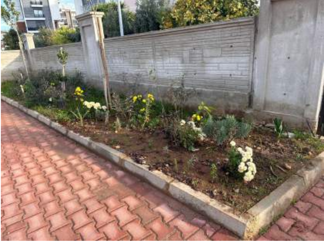
H.Karakaş Mahallesi Uhud Cami Bahçe Çevresi Bordür Çalışması
