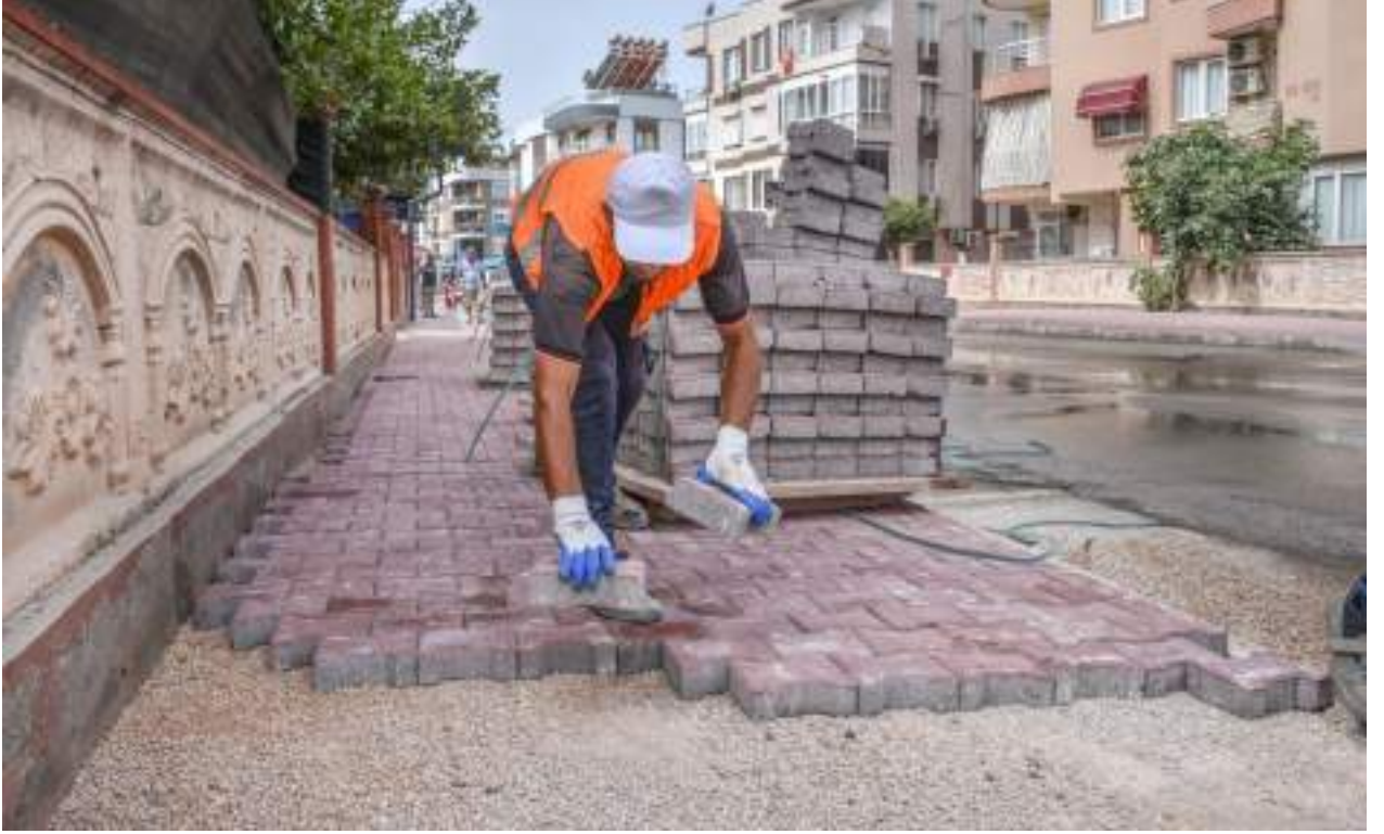
Karşıyaka Mahallesi Kaldırım Çalışması
