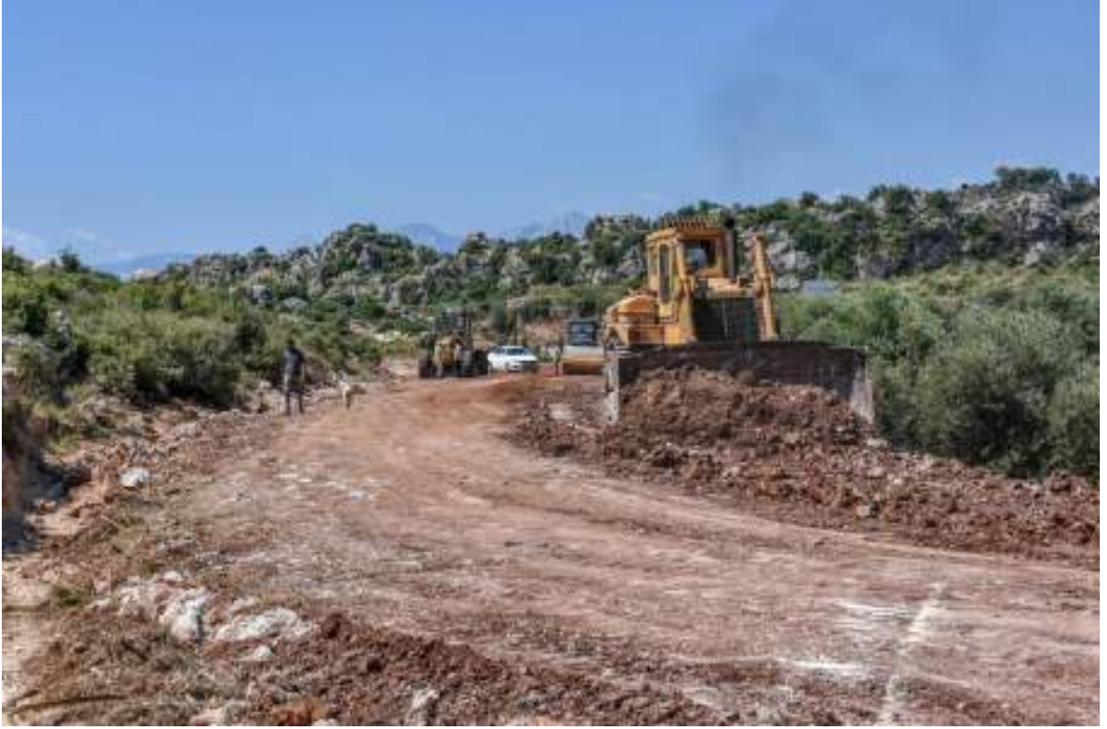
Yavuz Selim Mahallesi Yeni Yol Çalışması
