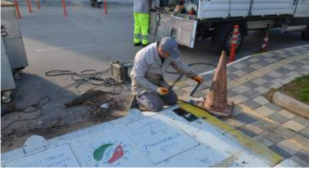
Yer altı konteyner bakım ve onarımı
