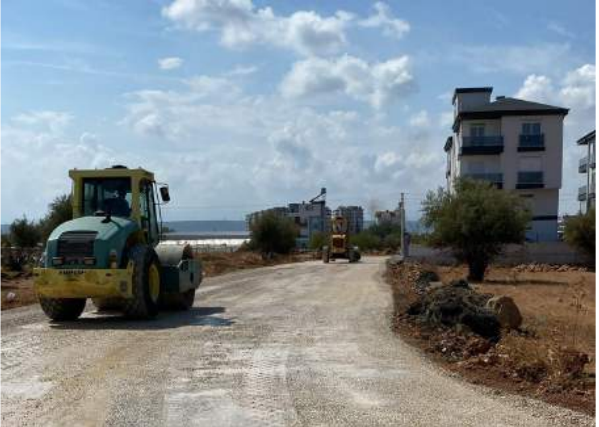
Zeytinlik Mahallesi Stabilize Yol Çalışması
