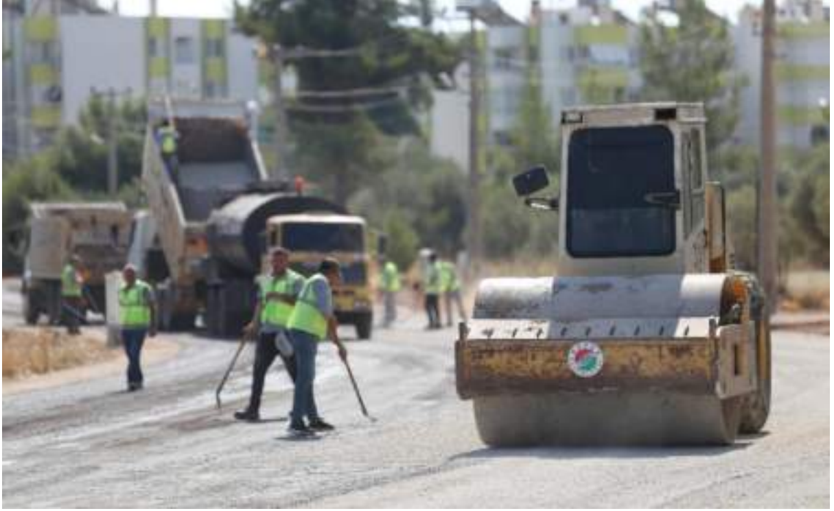
Aydoğmuş Mahallesi Sathi Kaplama Asfalt Çalışması
