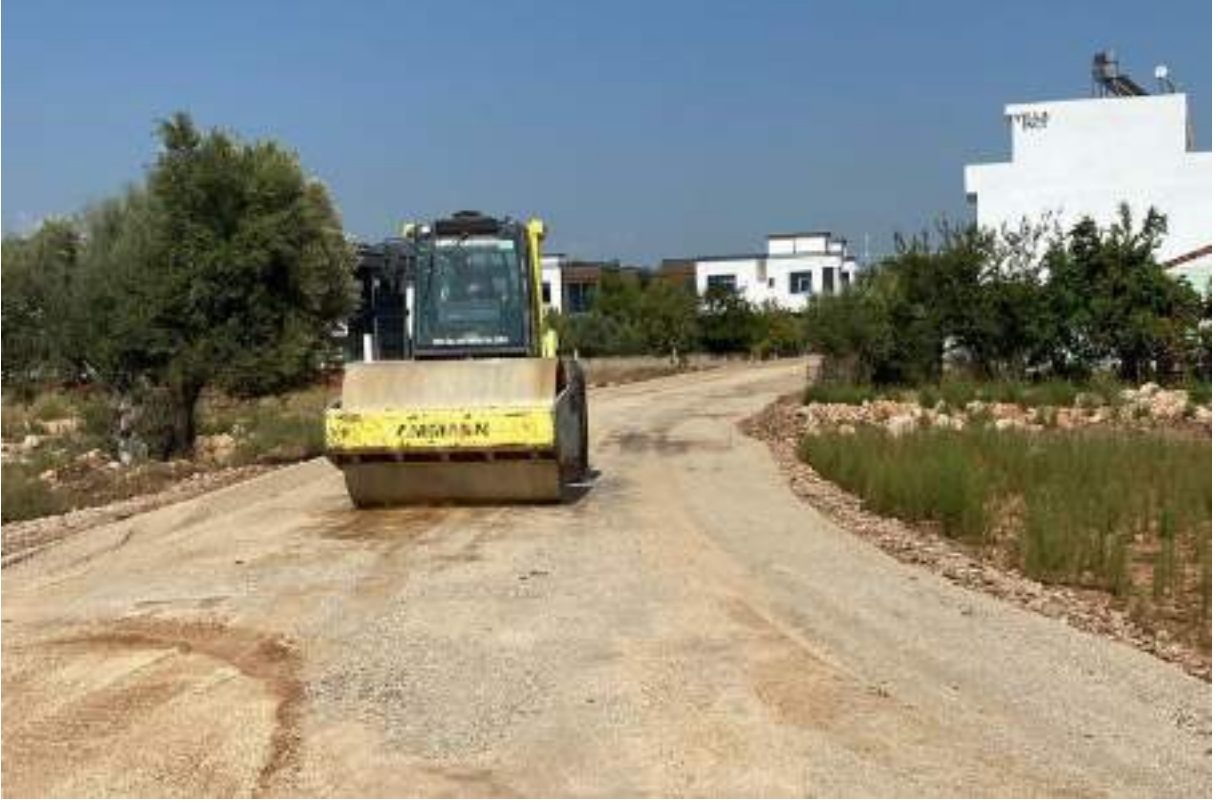
Odabaşı Mahallesi Stabilize Yol Çalışması
