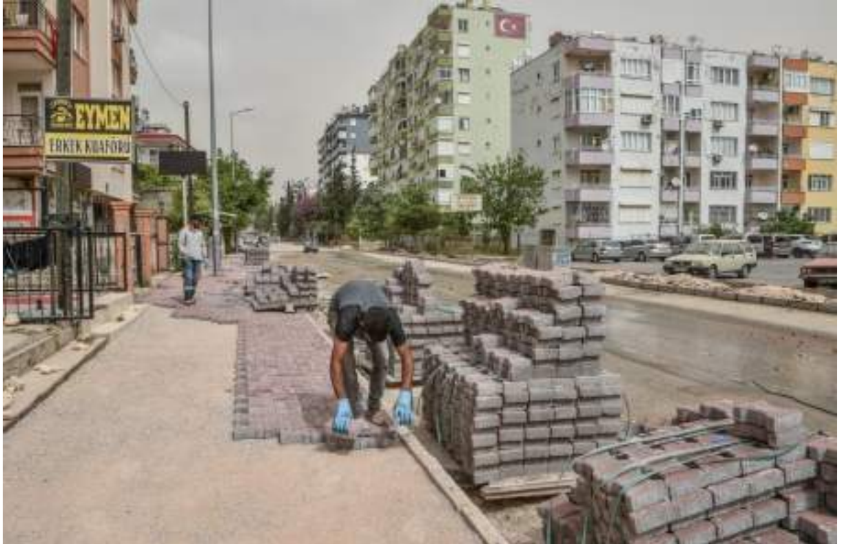
Düdenbaşı Mahallesi Kaldırım Çalışması
