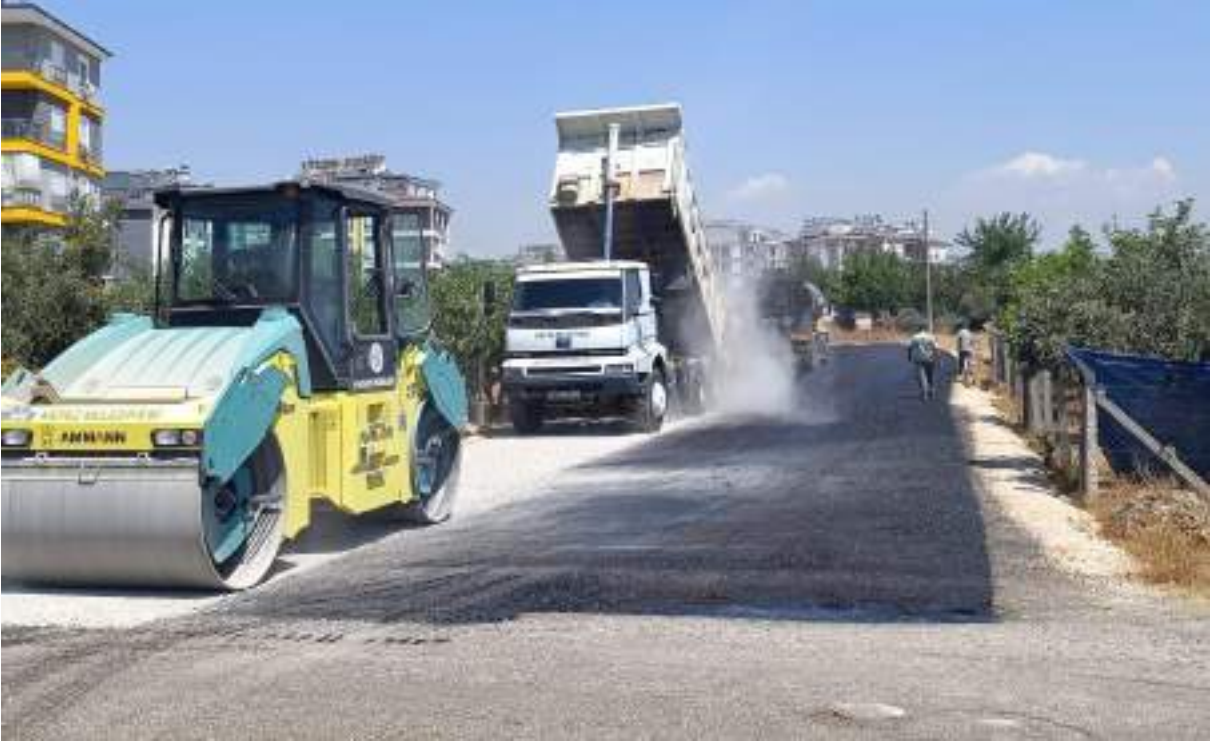
Altıayak Mahallesi Sathi Kaplama Asfalt Çalışması
